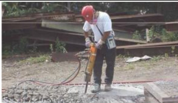
Uso di martello pneumatico a umido
