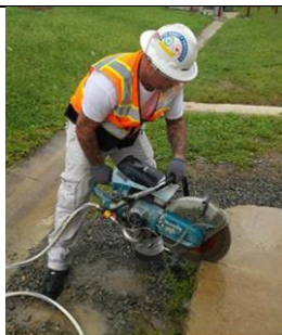
Uso di sega elettrica portatile ad umido
