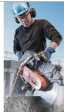
Uso di sega da muratore ad acqua
