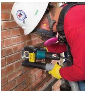
Smerigliatura con aspirazione della polvere
