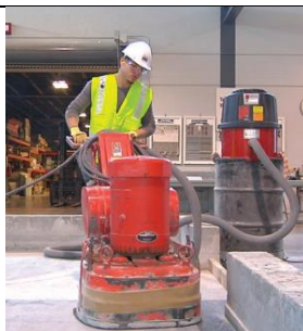
Fresatura con aspirazione della polvere
