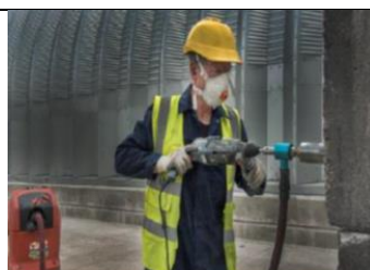
Carotaggio con aspirazione della polvere
