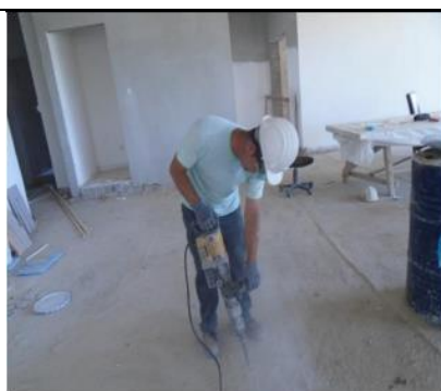
Uso di demolitore senza aspirazione della polvere
