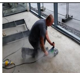
Levigatura senza aspirazione della polvere
