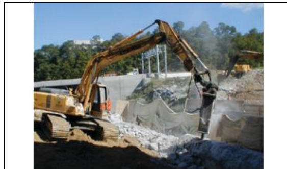
Escavatore dotato di cabina chiusa
