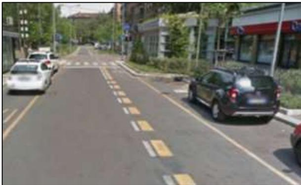
*Corsia ciclabile monodirezionale con sosta laterale (Milano). La dimensione minima della corsia è di 130 cm. per tener conto del maggior franco richiesto dalla sosta. La sosta deve essere longitudinale o, se inclinata, con accesso retroverso. Tale soluzione è realizzabile sulla base di un parere rilasciato al comune di Roma (M\_INF-SISTRA\_DIV2 prot.0005537-16.06.2017).*
