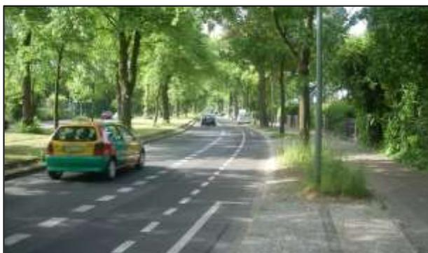
*In assenza delle dimensioni minime per disegnare le due corsie oltre alla corsia ciclabile, e non potendo impedire la circolazione dei ciclisti, è inevitabile dover rinunciare alla doppia corsia. Nel caso di esempio (Berlino) si è correttamente inserita la fascia ciclabile, oltre ad alcuni stalli di sosta.*
