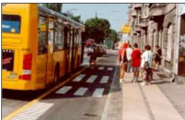
*Lo schema danese prevede di disegnare un attraversamento pedonale zebraato, di larghezza ridotta, in corrispondenza delle porte di salita/discesa del bus.*
