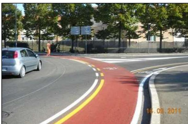
*Esempio di inserimento di una pista ciclabile monodirezionale in una rotatoria con diametro di 28 metri: la corsia ciclabile può essere riportata direttamente in corona, senza tuttavia allargare la sede carrabile; tale indicazione infatti riveste sostanzialmente il significato di sottolineatura della presenza ciclabile e di segno di continuità dei percorsi. È preferibile tratteggiare l'intera segnaletica di demarcazione della corsia.*
