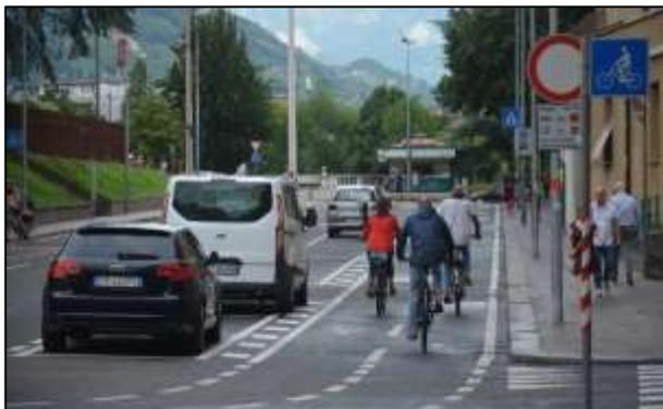
*Corsia ciclabile bidirezionale protetta dagli stalli di sosta (Bolzano). Le dimensioni del percorso consentono il sorpasso agevole tra ciclisti senza particolare pericolo in caso di apertura delle portiere.*
