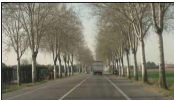
*Banchine ordinarie di ampiezza tale da costituire un percorso 'naturale' per le biciclette (min. 1,75 mt.). Utilissime, non abbisognano di altri interventi se non quello della regolare manutenzione e pulizia. Si sottolinea come in questo modo la protezione ciclabile lungo una strada di dimensioni geometriche inadeguate può essere garantita allargando la strada anziché costruire una pista separata. Si aumenta in tal modo enormemente la redditività dell'investimento (vedi cap. 4.2.6 e cap. 5).*
