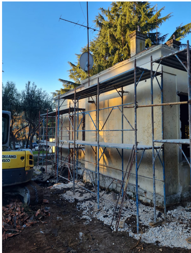
I lavori di ristrutturazione del Centro per la pesca e l'acquacoltura di Rovigno
