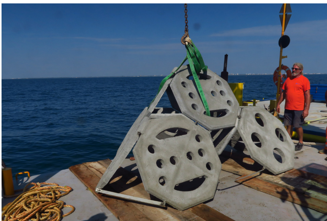
Posizionamento dei TecnoReef presso l'area pilota di Lignano Sabbiadoro
