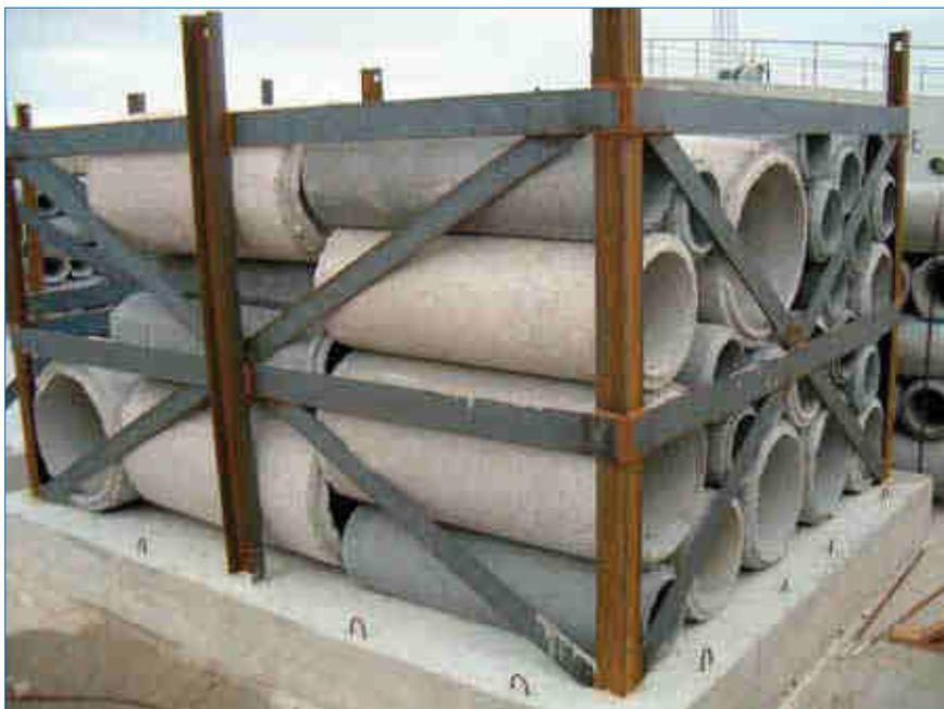
Figura 10. Barriera Artificiale "Tipo1".
