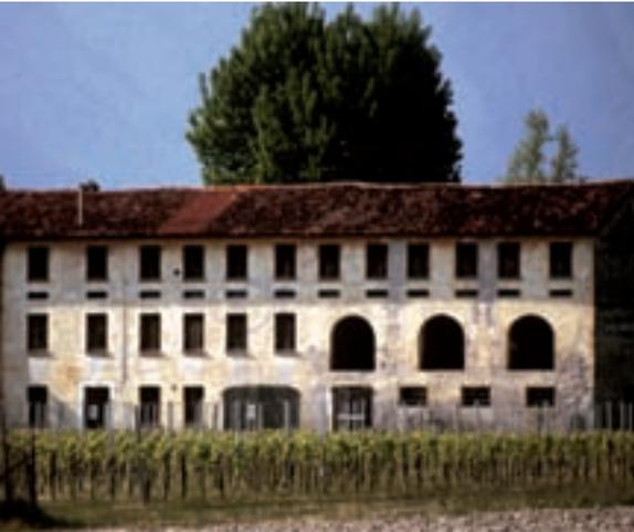
Camolli di Sacile. Bell'esempio, molto interessante anche sul piano architettonico, di casa colonica: da notare il grande solaio per la conservazione delle derrate per una famiglia numerosa, la stalla con i tre archi dei finestroni del fienile.
