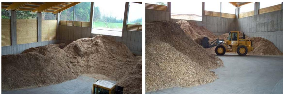
Al di sopra della parte basale in cemento, le pareti devono essere costruite con tavole di legno tra di loro distanziate (di pochi centimetri), per favorire l'aerazione dello stoccaggio e la fuoriuscita dell'aria umida. Molto importante è lasciare un vano luce di 1-2 m tra il tetto e la parete per favorire il più possibile la ventilazione interna della copertura e l'eliminazione dell'acqua di condensazione.
