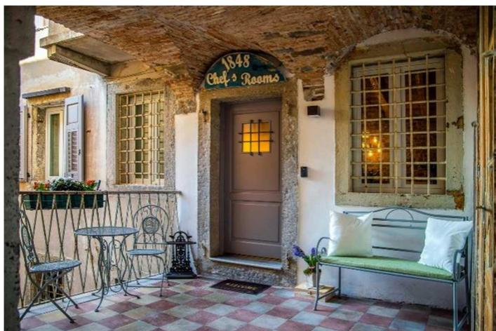
Gli interventi, iniziati in una prima fase nel 2019, hanno visto, attraverso un restauro conservativo mirato al ripristino delle caratteristiche della struttura, far riemergere vecchie pietre facciavista, volte in mattoncini e travi secolari.
