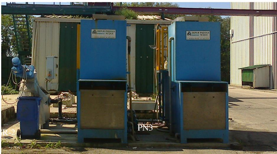
Figura 24: Immagine della filtro coclea e dei due impianti di pretrattamento chimico-fisico
