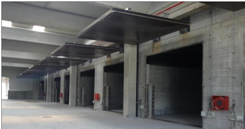
Figura 4. Fermentatori anaerobici in corso di costruzione
