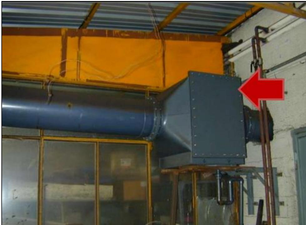
Il filtro di abbattimento è costituito da batterie alettate in PVC, poste in serie, come da Figura sotto.
