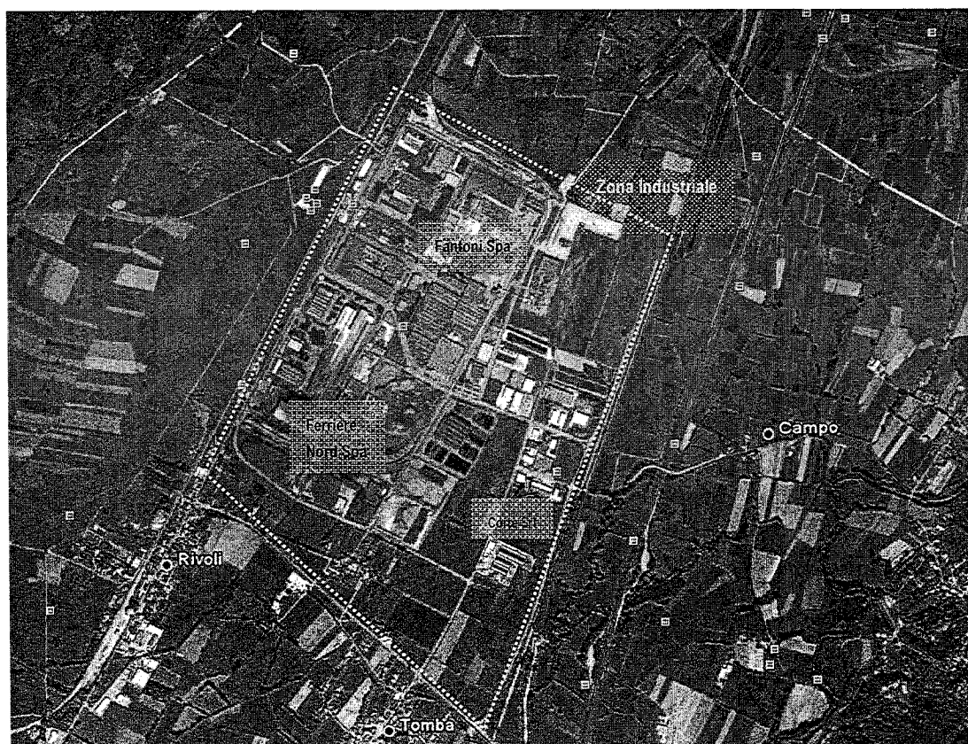
Figura 1: vista aerea della Z.I. CIPAF
