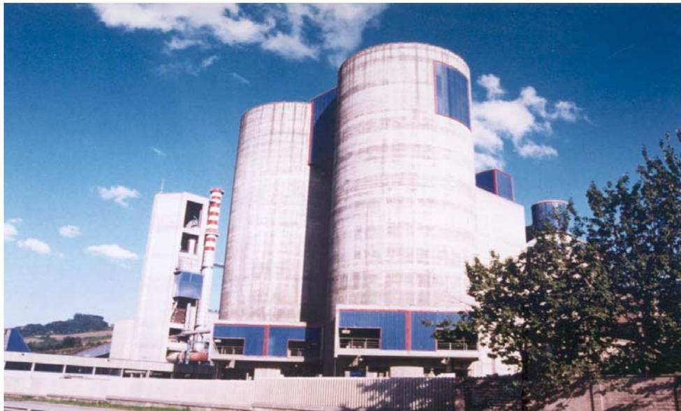
In particolare, la produzione di clinker avviene mediante **una linea di cottura** che utilizza il processo detto a "via secca", caratterizzato dal fatto che le materie prime, macinate ed omogeneizzate, vengono introdotte nel forno di cottura allo stato di polvere secca.
