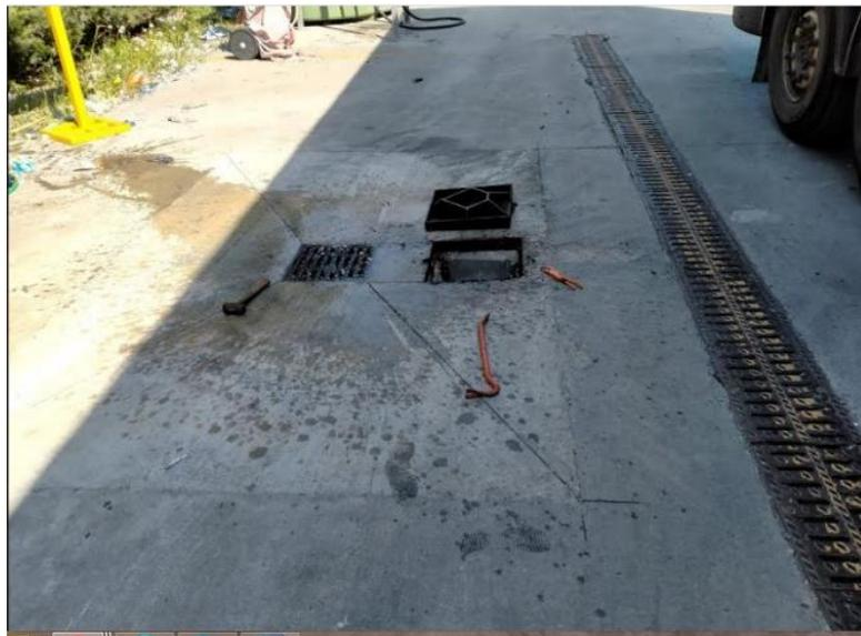
Figura 7-1 Bacino di confinamento (perimetro identificato in rosso), pozzetto centrale di raccolta degli sversamenti, pozzetto laterale nel quale è collocata la valvola manuale che collega il pozzetto di raccolta alla caditoia che conduce le acque all'impianto di depurazione
