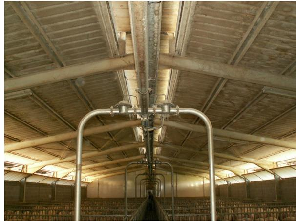
Foto 08: cupolini con apertura manuale e dettaglio impianto di distribuzione della broda
