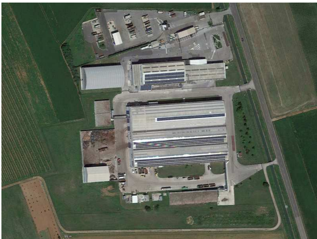
Figura 1-1 – vista aerea del sito (fonte: Google earth 2015)
