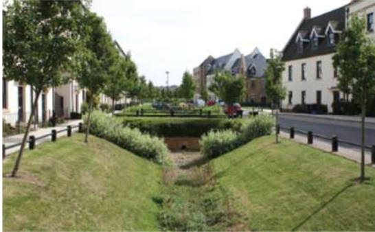
Esempio di canale vegetato asciutto
