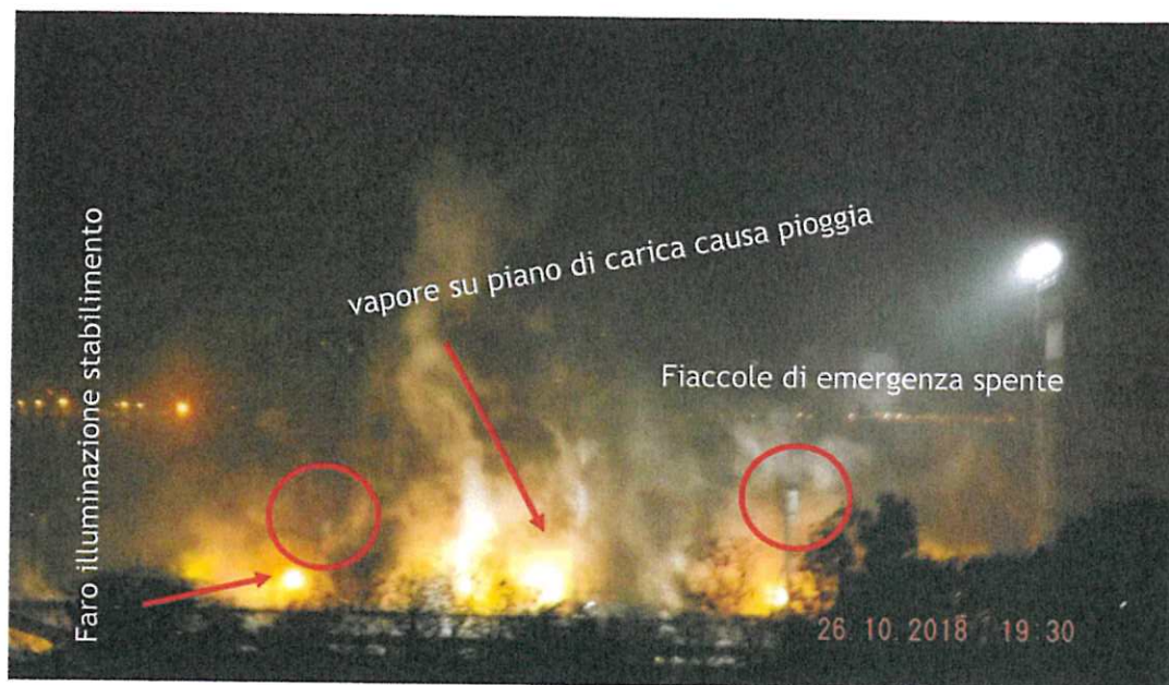
Fig. 4 – Evidenza delle fiaccole spente e della visione dall'alto della situazione di cui alla fig. 3
