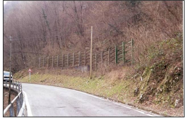
Figura 24 - Interventi di strutture paramassi (Fonte: IFFI).
