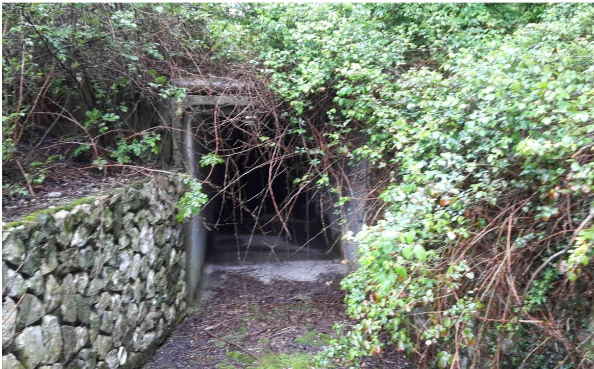
*Fig. 3.12 - Canale di by-pass della soglia in c.a..*
