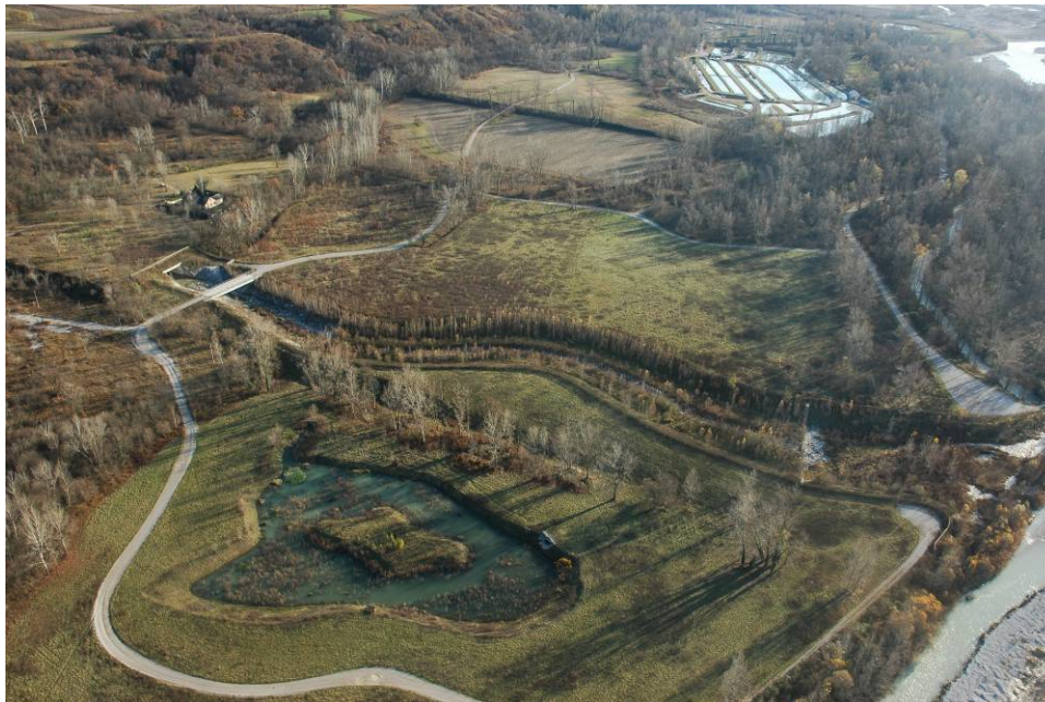
Figura 1.14.2: vista aerea del manufatto di restituzione sul Tagliamento
