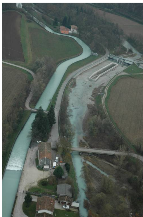
Figura 1.14.1: vista aerea del manufatto scolmatore
