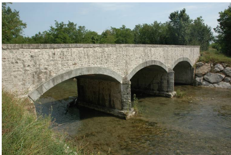
Figura 1.7.1: immagine del ponte di Barazzetto
