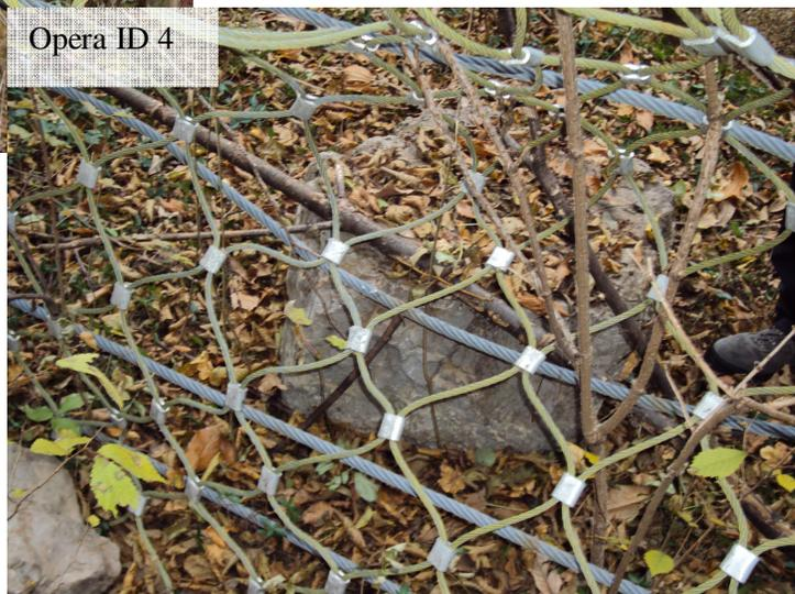
**Figura 5.10: Esempi di danneggiamento delle opere presenti a Villa Santina, in particolare nell'opera con ID 4 si osserva un blocco collocato oltre la rete e la relativa, seppur parziale, risaldatura del foro creato dall'impatto.**
