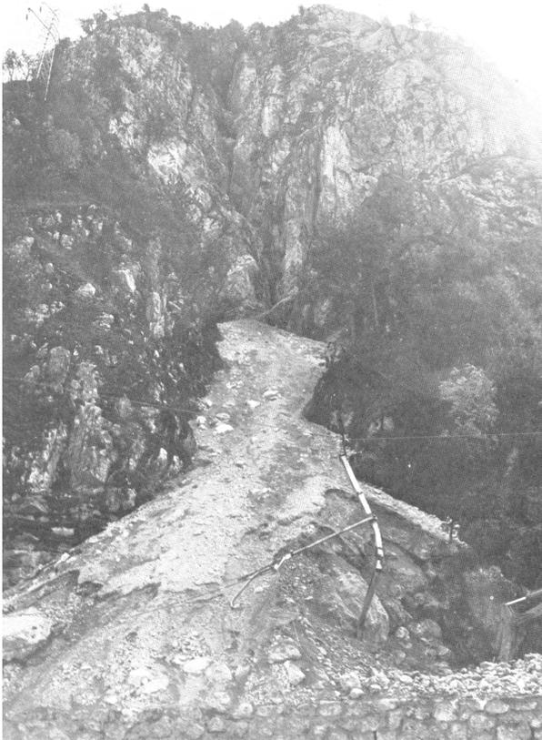
**Figura 4.11: versante sinistro della bassa Val Fella. Materiale prevalentemente fine incanalato entro una rapida incisione a seguito del terremoto di maggio, rimobilizzati e accumulati sulla sede della linea ferroviaria per effetto delle scosse di settembre.**
