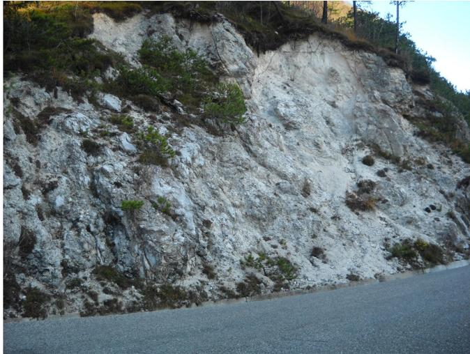
**Figura 2.20 Cataclasite in Dolomia Principale al tetto della Linea della Val Resia.**
