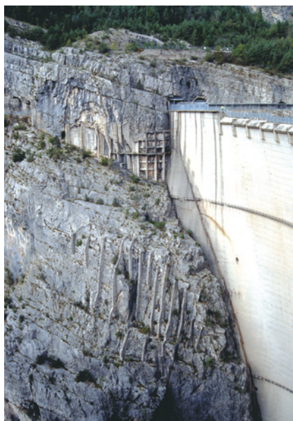
fig. 35 - Le spalle della diga del Vajont impostate sul calcare dell'omonima formazione.
