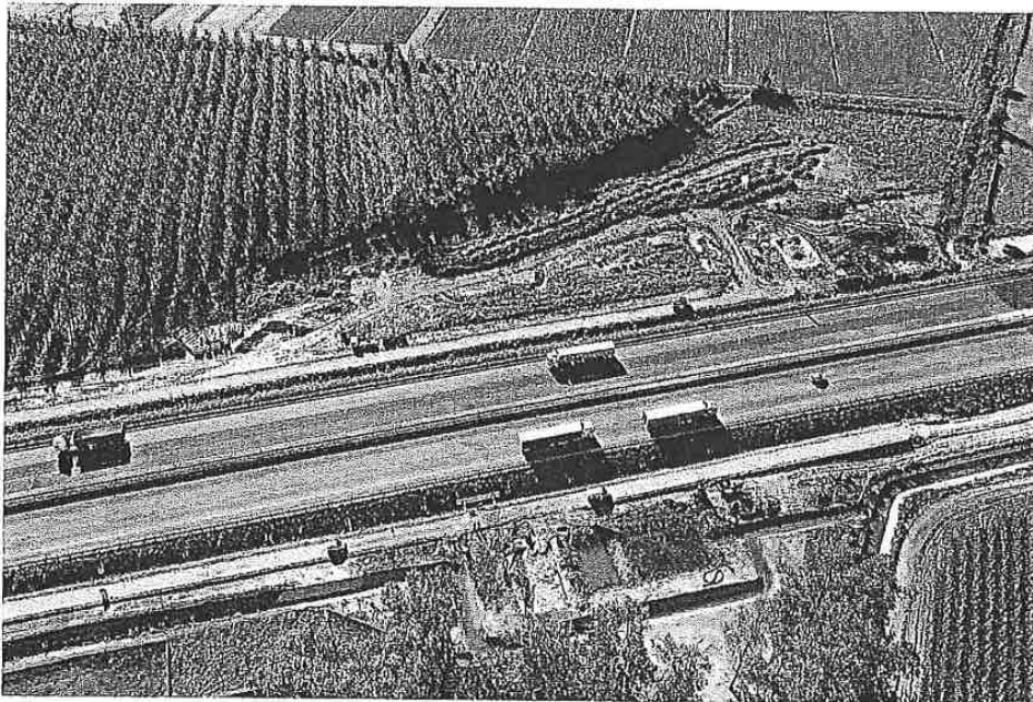
Lavori di completamento della Terza Corsia fra Gonars e Il Nodo di Palmanova
