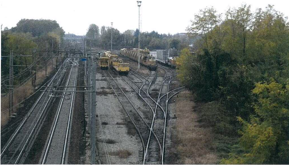
Vista dell'area destinata al cantiere di armamento, ora facente parte di uno scalo ferroviario, dal cavalcavia della Strada Statale n. 14 della Venezia Giulia.
