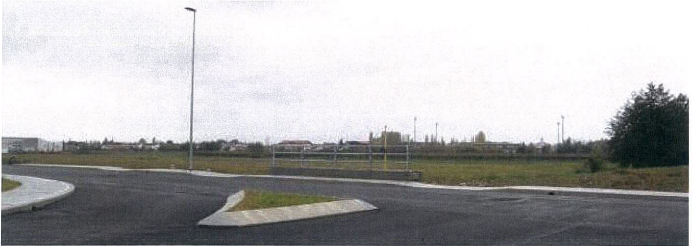
Vista dell'area destinata al cantiere operativo, con le recenti opere di urbanizzazione.
