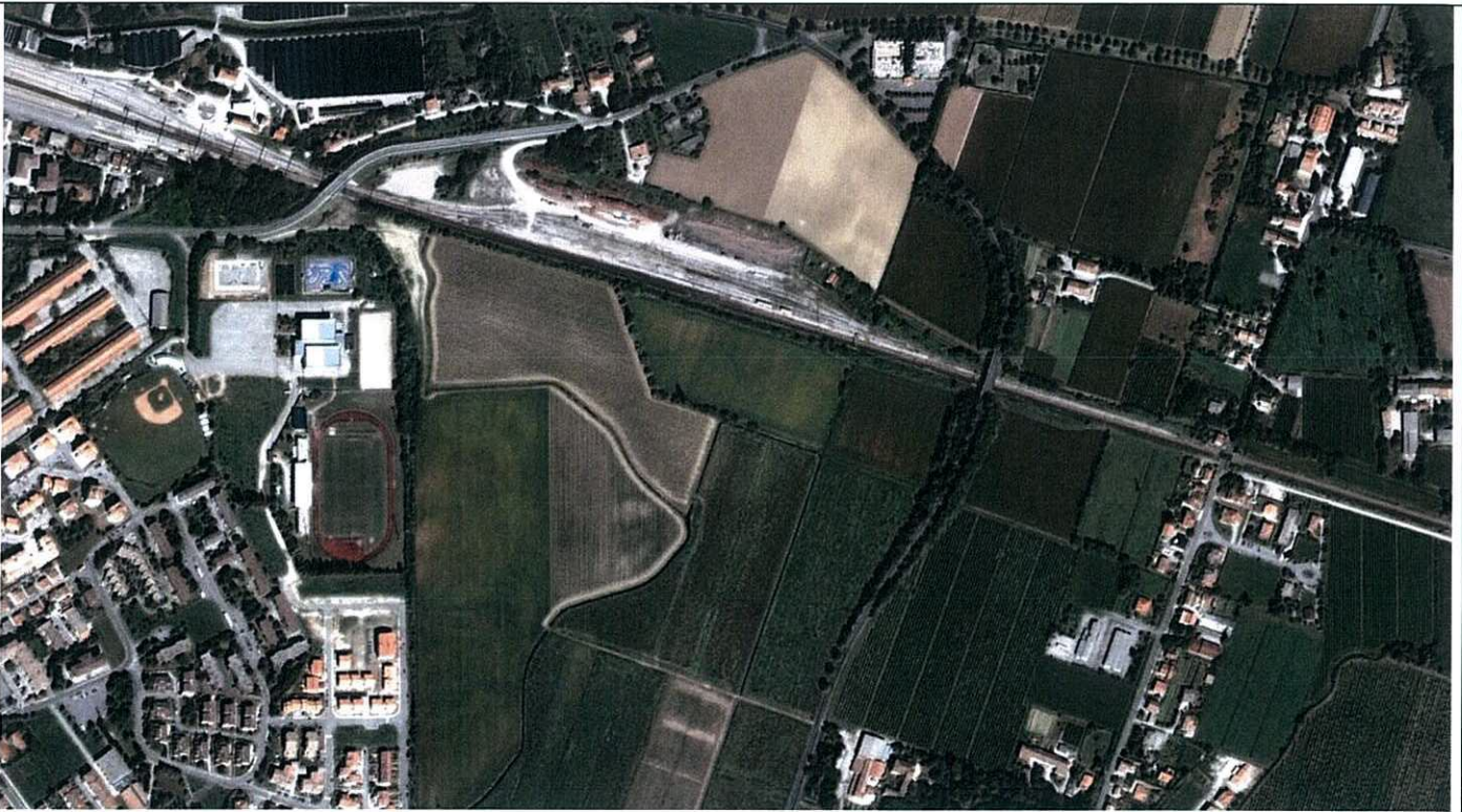
Vista aerea dell'area in cui si inserisce il cantiere operativo (Ortofoto da Google Earth).
