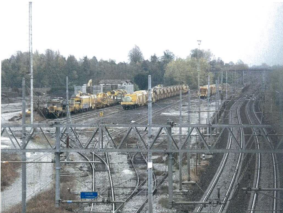
Vista dell'area destinata al cantiere di armamento dal cavalcavia della via L. Chozza.
