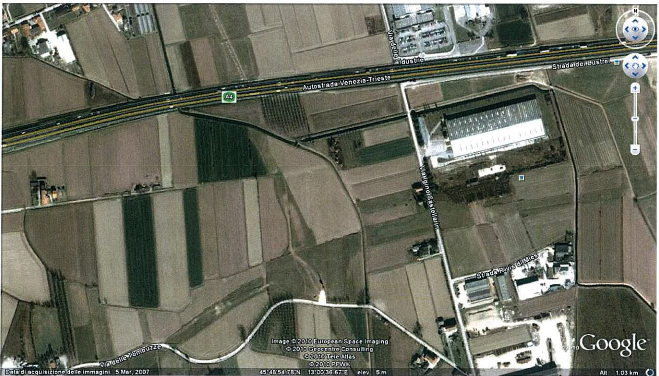
Vista aerea dell'area in cui si colloca il cantiere base (Ortofoto da Google Earth).
