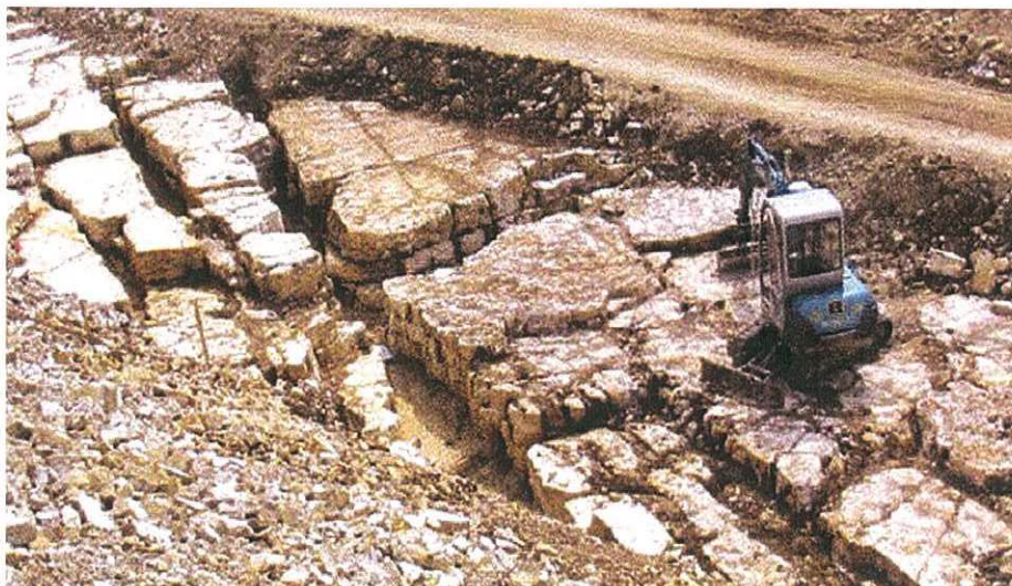
Figura 36 – fessure a reticolo superficiale
