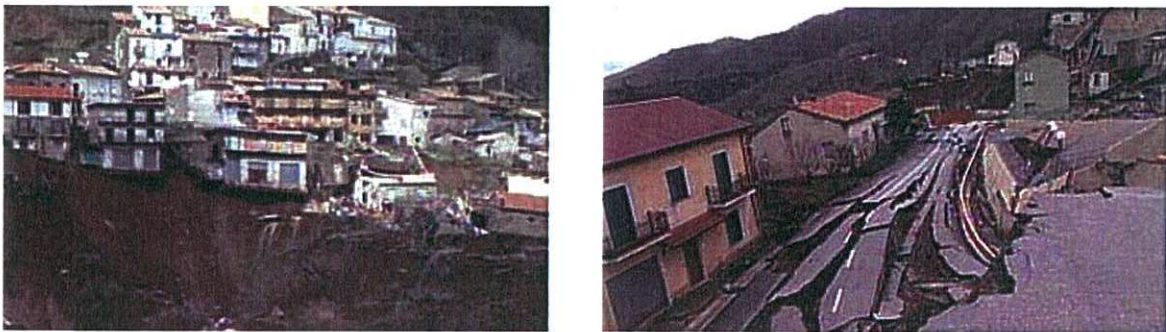
Figura 74: Frana di Cerzeto (CS).
