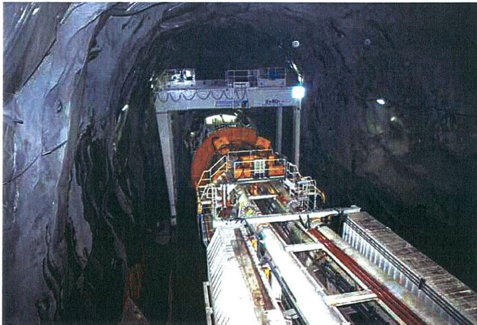
Fig. 11.5 - Camerone di lancio per una TBM (galleria S.Gottardo)
