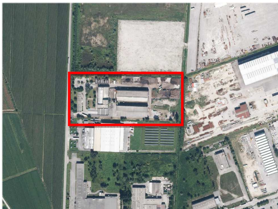
Figura 1. Vista aerea dello stabilimento ed aree limitrofe [fonte: IRDAT FVG – AgEA 2014]
