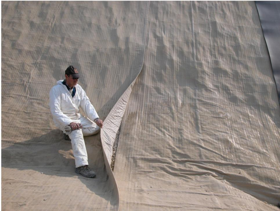
Il sistema applicato prevede una doppia impermeabilizzazione con interposizione fra le due di apposite tubazioni spia. Queste hanno il duplice fine di segnalare in corso di esercizio eventuali
