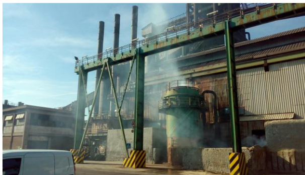
Foto 1. Episodio di accentuata fumosità in fase di granulazione della loppa proveniente dalla sommità della torre Ajo evidenziato nel corso dell'accesso in stabilimento del 23/09/2016, dovuto a un problema sul fine corsa della valvola di adduzione dell'acqua per l'abbattimento fumi.
