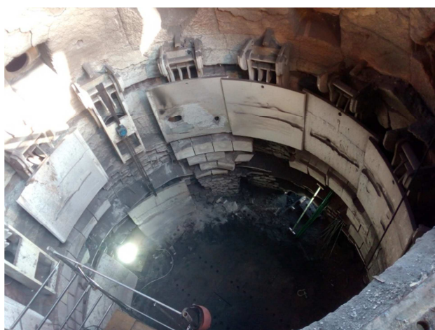
fase di sostituzione delle piastre mobili
