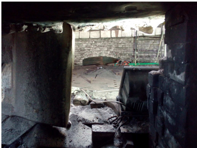
Particolare interno dell'altotino fotografato da un passo d'uomo nella muratura e nel mantello dell'altoforno.
