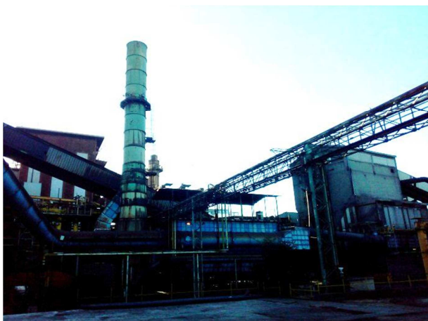
Impianto di depolverazione Daneco, asservito al campo di colata dell'altoforno n. 3.
