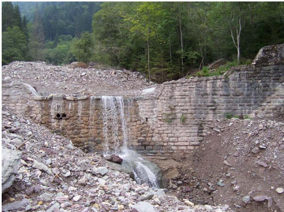
I lavori hanno riguardato la ricostruzione di parte del corpo centrale di una briglia in pietra e malta danneggiata dagli eventi alluvionali del 2003. Si è inoltre proceduto al ripristino delle sezioni di deflusso in alcuni tratti di alveo per permettere la transitabilità delle strade di accesso alle malghe ed ai complessi boschivi.
