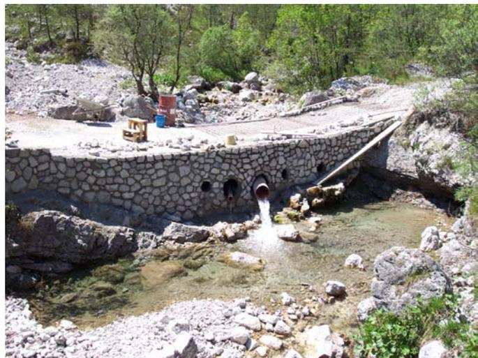
I lavori si sono resi necessari per ripristinare la sezione di deflusso del torrente nel tratto a monte del guado e rivestire il manufatto in calcestruzzo con pietre del luogo.
