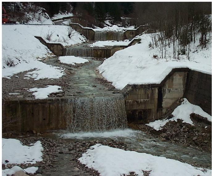
L'alluvione del 29 agosto 2003 ha gravemente danneggiato le gavete del T. Aupa. Si è quindi proceduto al rifacimento del coronamento delle opere e al ripristino di quei tratti di paramento lesionati mediante betoncino e rete elettrosaldata.
