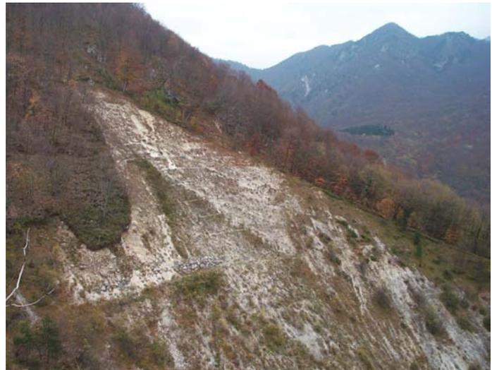
I lavori sono consistiti nella manutenzione di una frana sistemata nel 1990 e denudata a causa dell'aridità dei suoli mediante la formazione di cordone vive e l'inerbimento mediante "mulching" inoltre è stata sistemata la pista in corrispondenza di alcuni tornanti con la realizzazione di selciato in calcestruzzo. Sono stati anche sistemati due cedimenti della scarpata a valle mediante la realizzazione di geomuri ed opere in legname e pietrame.
