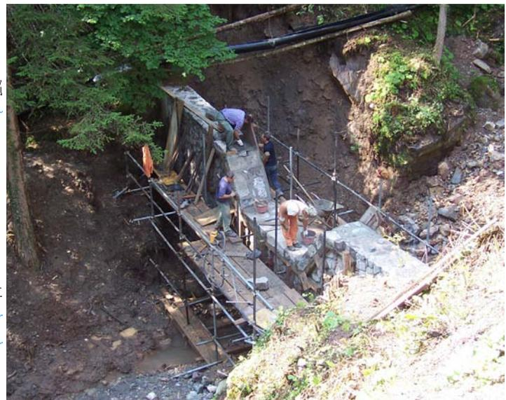
L'intervento è consistito nella ricostruzione di una soglia in pietrame e malta a valle del ponte della strada comunale Valpicetto – Calgaretto. Si è inoltre proceduto al ripristino delle sezioni di deflusso ed alla ricarica con materiale inerte del versante sotto strada.
