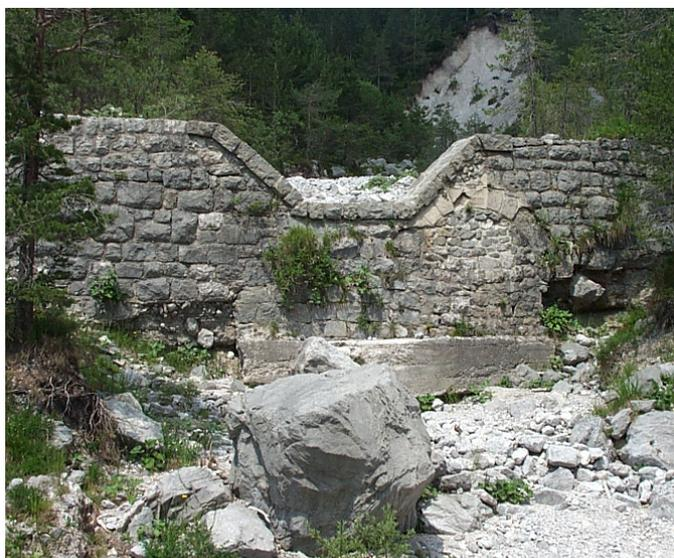
In località Plan dei Spadovai una traversa, ubicata in un affluente destro del T. Dogna, era gravemente danneggiata. La briglia è stata rinforzata con la realizzazione di una sottofondazione in calcestruzzo, mentre l'avanbriglia, le ali e parte del paramento centrale sono state ricostruite in pietra e malta rispettando la tipologia preesistente.
