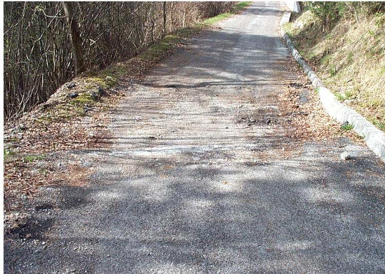
I guadi sono stati riprofilati con il raggio di curvatura più idoneo per consentire il passaggio dei mezzi spazzaneve.
