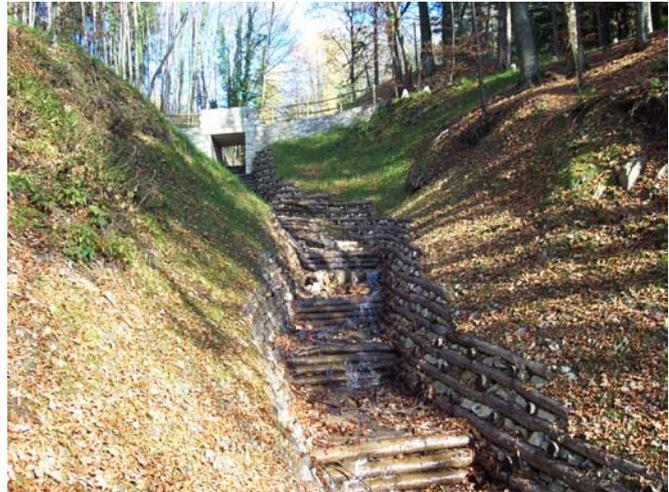
I lavori, resi necessari per ripristinare la sezione di deflusso e consolidare i versanti in dissesto, sono consistiti nella realizzazione di palificate in legname e pietrame con talee e ripristino di un tombotto in muratura di pietrame.
