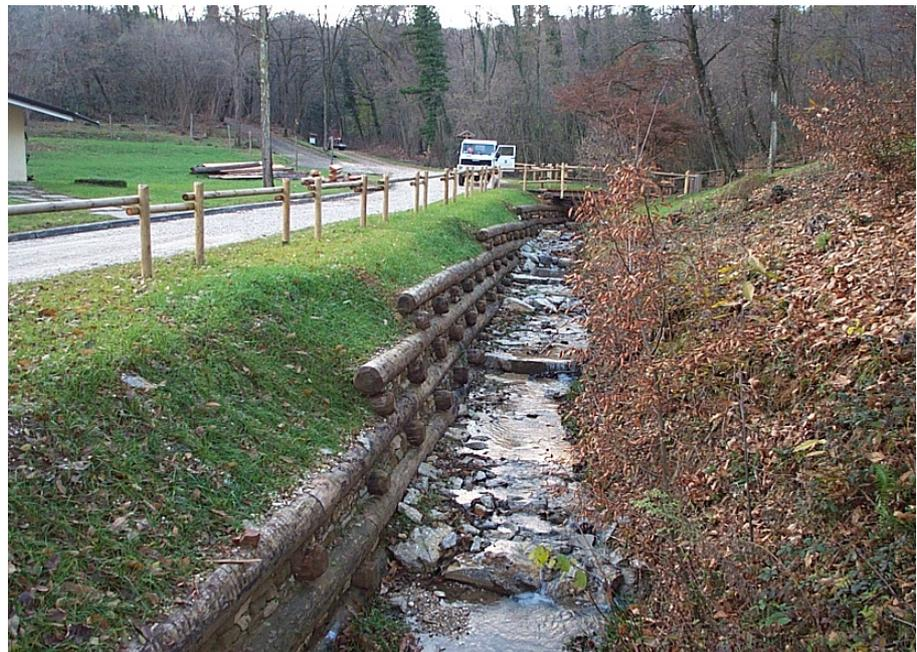
Il Rio, posto all'interno di un'area regionale adibita a parco, presentava le sponde erose per il deterioramento delle opere di sostegno realizzate in legname che sono state sostituite con tronchi di larice e pietrame interposto oltre al rifacimento di due ponticelli lungo il sentiero che percorre l'intera area.
