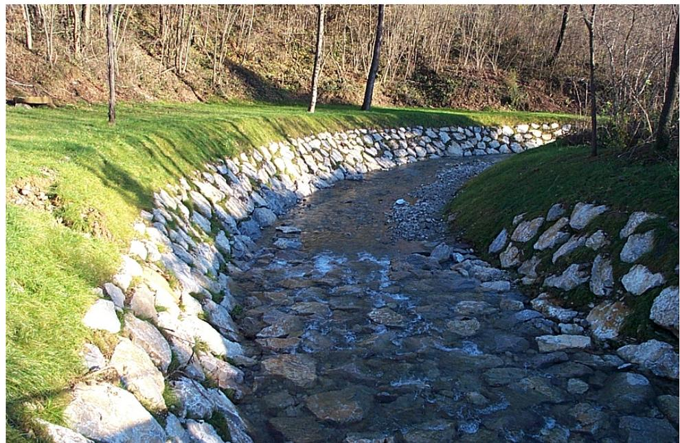
Ricostruzione delle scogliere spondali e ricalibratura dell'alveo.
