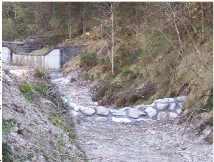
I lavori hanno riguardato il tratto di Rio a cavallo della strada statale e sono consistiti nel ripristino delle platee alla base della briglia a valle e di quella a monte della strada, nella realizzazione di due soglie in grossi massi inghisati e nella fugatura del selciatoone sotto il ponte.
