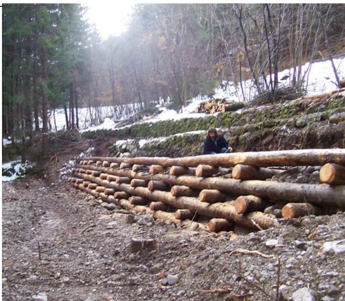
I lavori hanno riguardato per quest'anno la realizzazione di una palificata viva a sostegno della soprastante strada vicinale ed il taglio piante lungo l'intera asta del rio, in previsione il prossimo anno del ripristino delle sezioni di deflusso del rio, della ricostruzione dei guadi e ripristino di parte delle difese spondali in pietrame.
