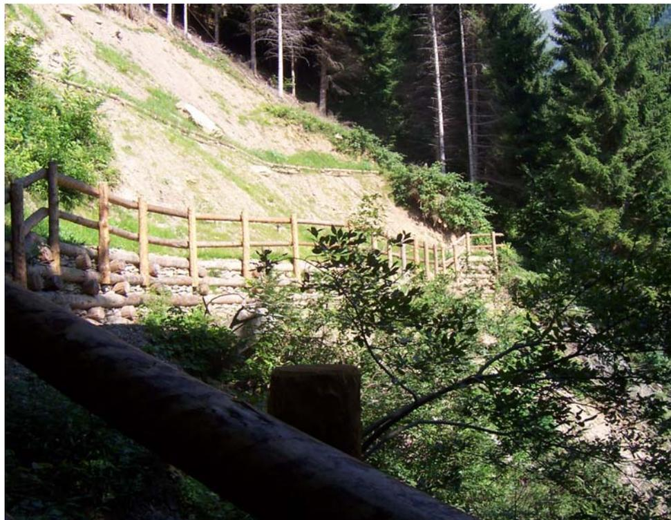
La sistemazione della frana si è resa necessaria per evitare che un ampliamento del movimento franoso potesse interessare e ostruire il corso del rio sottostante. Per le opere è stato utilizzato solo legname e pietrame. La superficie movimentata è stata poi anche consolidata con inerbimenti e piantumazioni.
