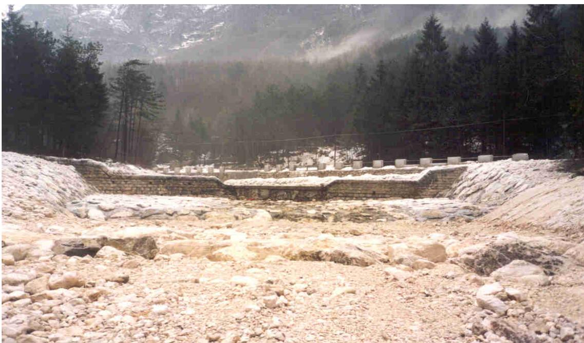
Tra l'abitato di Saletto e Tamaroz una briglia era gravemente danneggiata e le sponde a valle dell'opera in forte erosione. Si è intervenuti mediante il ripristino della traversa con una sottofondazione estesa a tutta la lunghezza e la creazione di una platea di dissipazione in grossi massi intasata in calcestruzzo. Sia in sinistra che in destra orografica è stat realizzata una scogliera al fine di ridare piede alle pendici.
