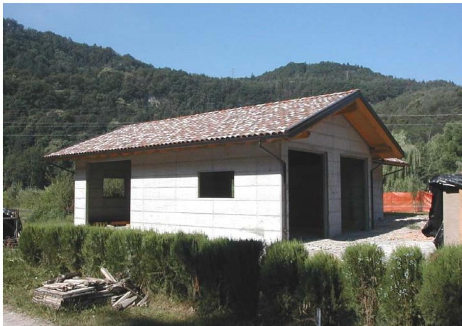
Realizzazione di un deposito mezzi antincendio con struttura in c.a. e copertura in legno. Ciò nasce dalla necessità sia di integrare e potenziare la struttura vivaistica sia di implementare la disponibilità di strutture e mezzi aventi finalità di antincendio boschivo. La superficie coperta è di circa 160.00 m<sup>2</sup>, con un volume v/p di 690 m<sup>3</sup>. Per un corretto inserimento paesaggistico – ambientale è stato privilegiato l'uso del legno e della pietra.
