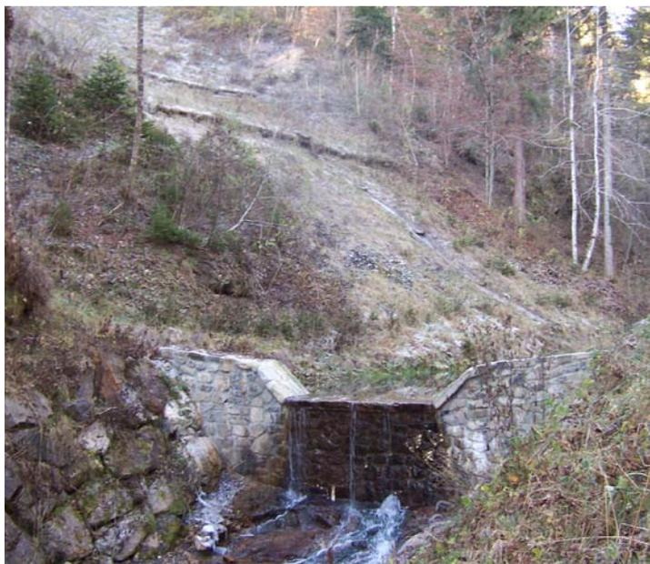
I lavori hanno riguardato il tratto intermedio del Rio e sono consistiti nel ripristino del paramento di un'opera in cls, nella ricostruzione di un'opera in pietrame e malta, nel ripristino di parte delle difese spondali sia in grossi massi che in legname e pietrame e nel ripristino delle sezioni di deflusso con contemporanea scolmatrice delle vasche di deposito.
