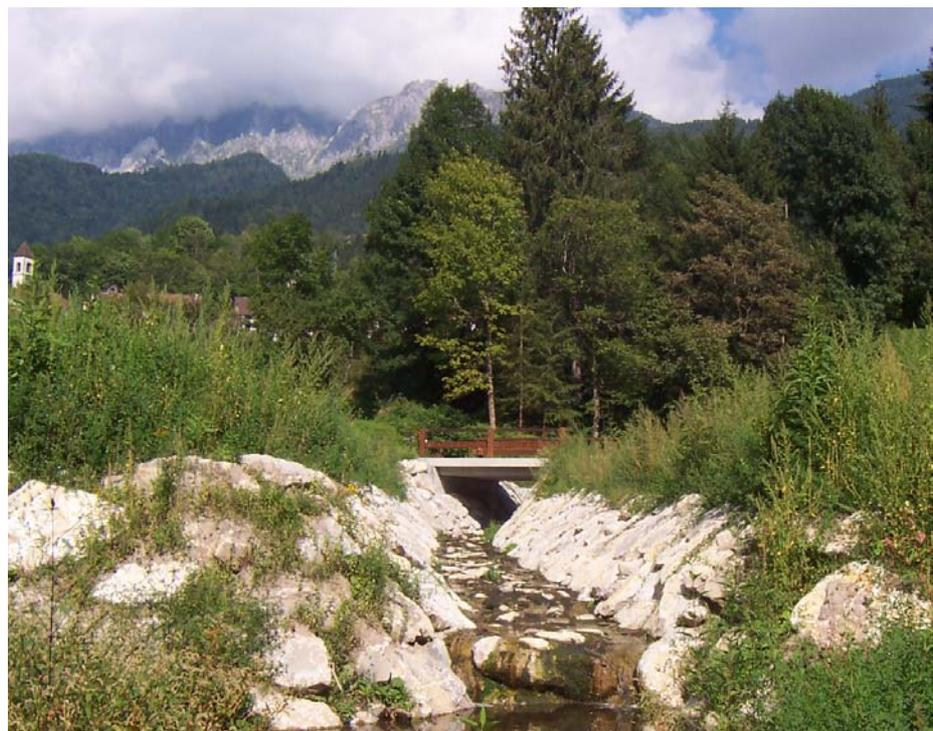
L'intervento consiste nel ridimensionamento del canale e dell'attraversamento stradale che erano di gran lunga sottodimensionati rispetto alla portata del rio. Per una migliore tenuta delle sponde il canale è stato rivestito in grossi massi e l'attraversamento stradale è stato garantito dal ponticello. La tipologia dell'intervento e la scelta dei materiali si adattano comunque molto bene all'ambiente circostante.
