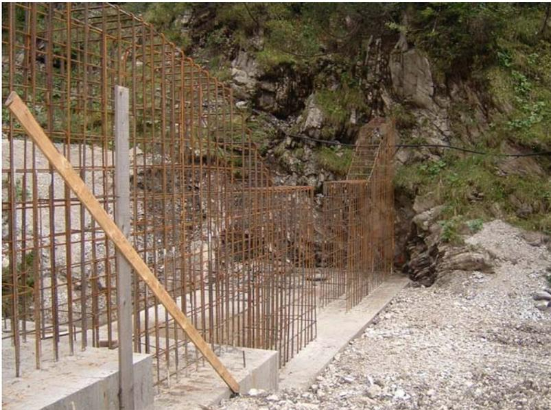
Realizzazione di un bacino di deposito in grado di regolarizzare il deflusso del materiale alluvionale proveniente dalla parte alta del bacino ed impedire che tale materiale vada ad ostruire il cunettono che a valle attraversa l'abitato.
