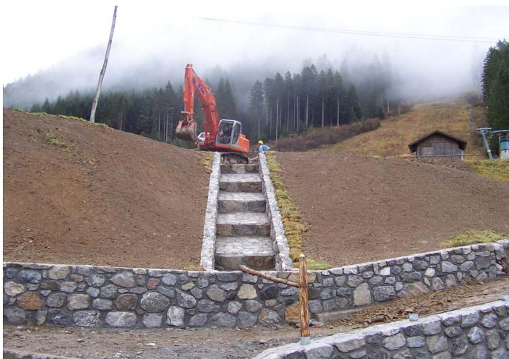
I lavori hanno riguardato il ripristino dell'efficienza idraulica di un aff.te del Rio Moraretto in loc. Canobbio che attualmente disperdeva le acque nei prati, interessando a volte anche gli immobili ed il campeggio attigui. Sono state realizzate delle opere in legname e pietrame nella parte alta per raccogliere ed incanalare le acque ed una canale in parte a secco ed in parte in muratura di pietrame e malta per convogliarle fino al rio Moraretto.
