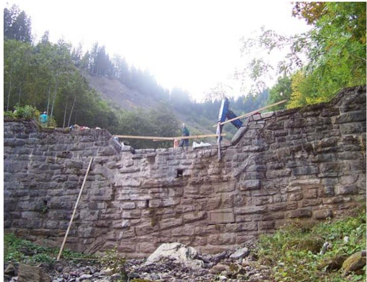
I lavori sono consistiti nella manutenzione delle opere in pietrame esistenti lungo l'asta del rio (ricostruzione di parti di gaveta, parziali sottofondazioni, ecc.), nel ripristino delle sezioni di deflusso e nel consolidamento con palificate vive di un tratto di versante in frana.
