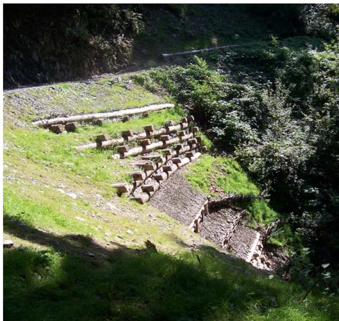
I lavori eseguiti nel corso del 2005 hanno riguardato il consolidamento di un impluvio a margine della pista forestale che porta in loc. Vintulis. Sono state realizzate delle palificate vive e poste in opera cordonate con talee di salice.
