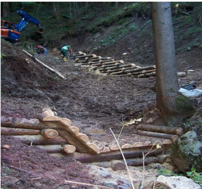
I lavori sono consistiti nel ripristino delle sezioni di deflusso di un piccolo affluente del Rio Costamezzana e nel consolidamento del fondo alveo e di alcuni tratti di sponda con soglie in legname e pietrame e palificate vive. Si è inoltre eseguita la pulizia e ripristino della funzionalità del canale in lamiera zincata esistente.
