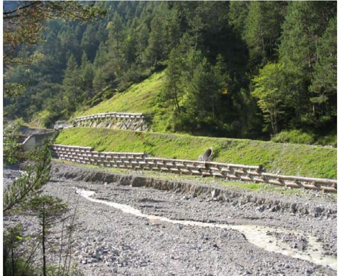
Il rio è caratterizzato da una profonda erosione con cospicuo trasporto solido ed è stato sistemato con 60 traverse. La pista di servizio alle opere viene garantita dalla realizzazione di un'opera mista in legname e pietrame in sinistra orografica. Un movimento franoso è stato consolidato con opere di ingegneria naturalistica. Inerbimento potenziato delle superfici interessate dai lavori.
