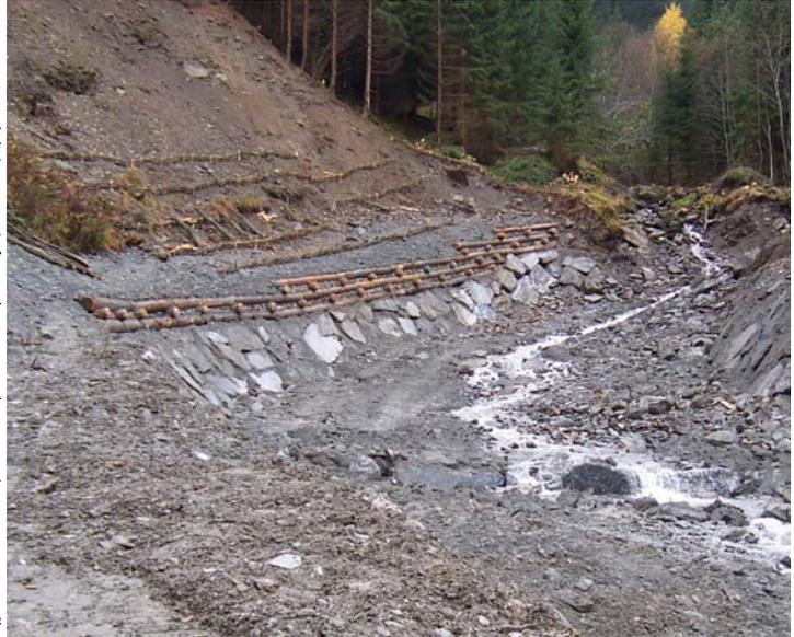
I lavori sono consistiti nel completamento delle difese spondali alla base di un tratto di versante in frana che rischiava di ostruire il corso del Rio. È stata realizzata una scogliera in grossi massi completata in sommità da una palificata viva. Sul versante sono state posizionate delle viminate in combinazione con talee di salice. Si è inoltre proceduto alla ricalibratura del rio fino alla sua confluenza con il torrente But.
