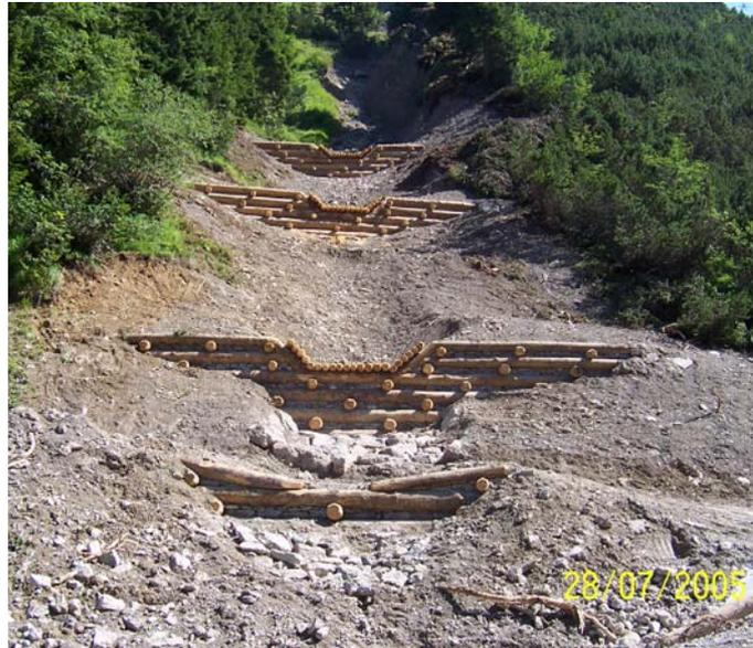
Nella foto sono messe in evidenza le soglie in legname e pietrame realizzate per consolidare l'alveo del rio e di un piccolo impluvio laterale.
