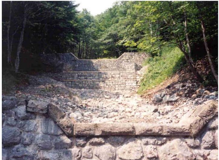
I lavori sono consistiti nella ricostruzione con gabbioni metallici riempiti di pietrame dell'avambriglio dell'opera posta subito a monte della strada, nonché nel taglio piante e ripristino delle sezioni di deflusso del rio nel tratto tra la strada e l'opera. Nel contempo si è proceduto al ripristino del guado in pietrame posto sulla strada.
