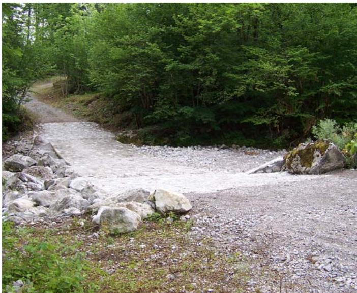
Sul T. Faeit è stato ripristinato e prolungato il guado presente sotto la frazione di Pusea. Si è proceduto anche al taglio piante e ripristino delle sezioni di deflusso del tratto di alveo a monte ed a valle del guado.
