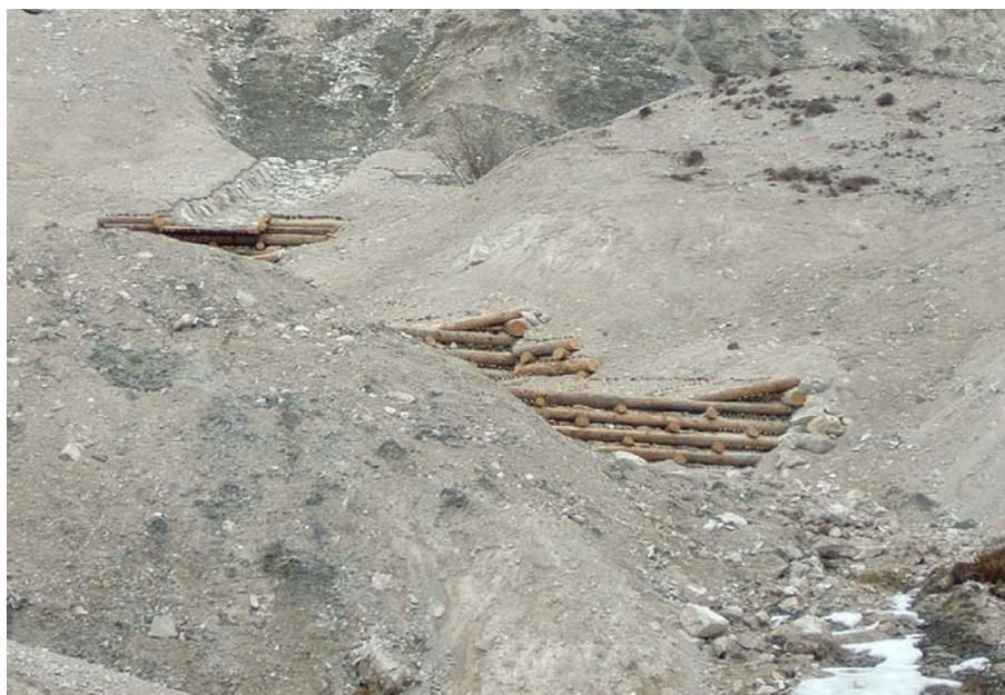
Oltre a interventi di inalveamento e di ricostituzione spondale, sono stati realizzati degli interventi di ingegneria naturalistica (palificate, palizzate, gradinate, canali di raccolta acque) per stabilizzare il versante in destra orografica.
