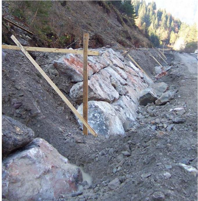
I lavori sono consistiti nel ripristino e completamento di un tratto di circa 120 m di difesa spondale in gossi massi alla base di un tratto di versante boscato in progressivo arretramento con conseguente caduta in alveo di piante di altofusto.
