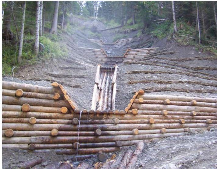
I lavori hanno riguardato il consolidamento di un versante in frana in sponda destra del Rio di Plumbs, frana che aveva ostruito l'alveo e provocato danni all'attigua viabilità forestale. Sono state realizzate tre palificate vive ed un tratto di canale in legname. I versanti sono stati riprofilati e consolidati con viminate vive ed idrosemina. Si è inoltre intervenuti anche sulla viabilità di accesso realizzando una palificata viva di sostegno alla sede stradale.
