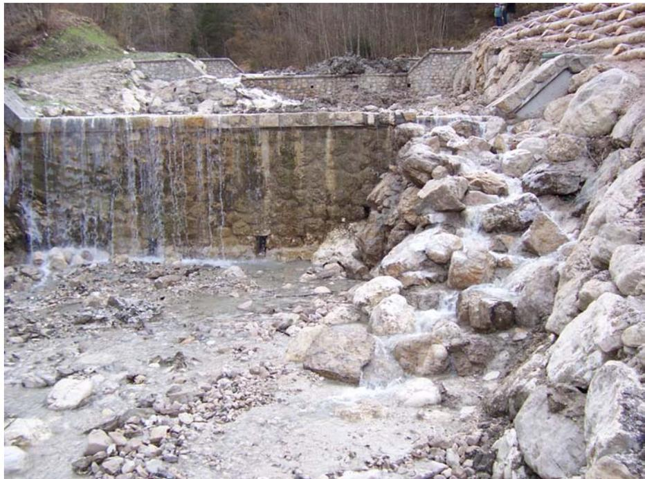
I lavori si sono resi necessari per la manutenzione delle opere idrauliche in precario stato di efficienza, realizzazione di una pista di servizio, consolidare il versante in sinistra orografica. Sono consistiti nella realizzazione di: tre briglie in calcestruzzo rivestito con pietrame, difese di sponda in grossi massi, rampe di monta per la risalita della fauna ittica e palificate in legname con talee, taglianti drenanti a sezione trapezia, cassonetto stradale drenante.
