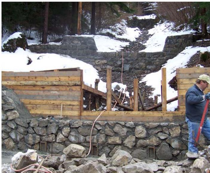
I lavori hanno riguardato il ripristino di una soglia in pietrame e malta ed il ripristino della transitabilità del guado mediante la realizzazione di una nuova soglia e del relativo selciatoone, sempre in pietrame e malta. Contemporaneamente si è provveduto al taglio piante e ripristino delle sezioni di deflusso del tratto di rio interessato dai lavori.
