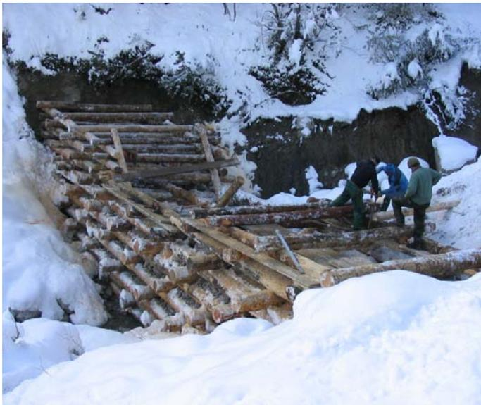
A monte del ponte sulla strada che porta al rifugio Giau una traversa è stata asportata. Viene quindi realizzata un'opera trasversale in legname e pietrame per mantenere la quota di fondo dell'alveo.
