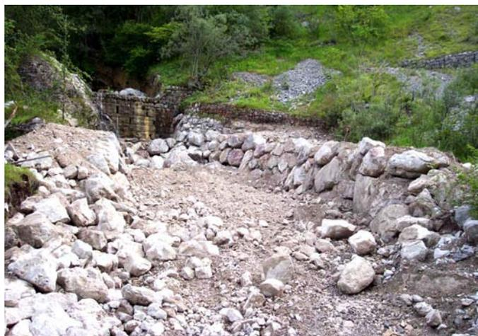
Sifonamento della briglia e del muro di sponda; intervento di ripristino in grossi massi.
