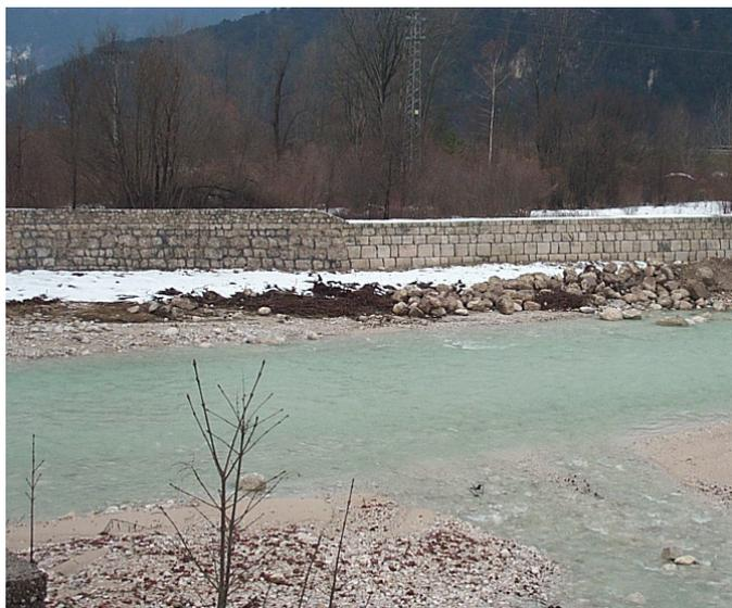
In prossimità della confluenza con il Fiume Fella gli argini sono stati oggetto di manutenzione mediante il taglio della vegetazione soprastante e in alveo, la pulizia del paramento, il rifacimento dei tratti mancanti o danneggiati e la fugatura dei giunti. Grossi massi sono stati posizionati al piede del muro in modo da proteggerlo da eventuali scalzamenti.
