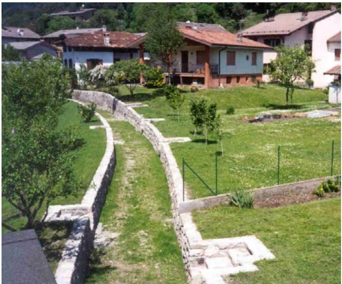
Un affluente del T. Faeit che attraversa l'abitato di Cavazzo Carnico è già stato oggetto di sistemazione negli anni scorsi. Il tratto in prossimità di un vecchio mulino era gravemente danneggiato. Sono stati ricostruiti tutti i muri spondali, comprese le strutture del mulino in alveo, sempre in pietrame e malta, con piccole soglie di fondo. Sono state mantenute e ricostruite le scale di accesso al rio e i vecchi lavatoi.
