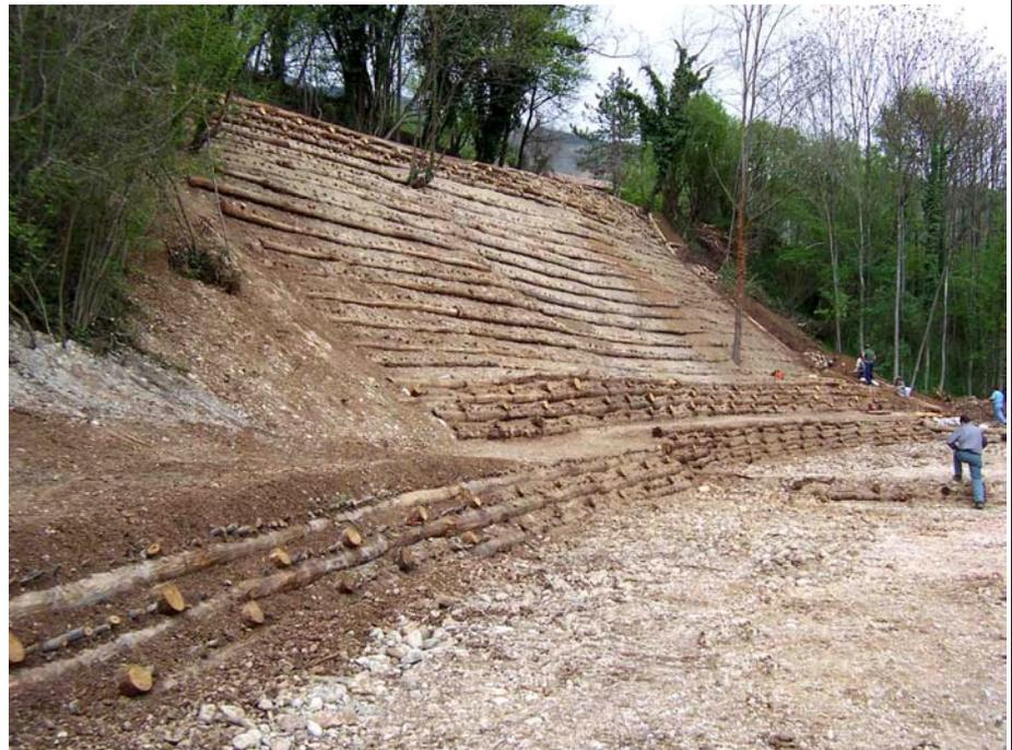
I lavori si sono resi necessari per impedire il protrarsi dell'erosione al piede del versante che avrebbe interessato la strada soprastante e sono consistiti nella realizzazione di una grata in legname con talee e una serie di palificate in legname con talee al piede e in testa alla stessa. Si è provveduto inoltre al ripristino della sezione di deflusso del rui de Brosa con una serie di opere in legname (palificate e soglie).
