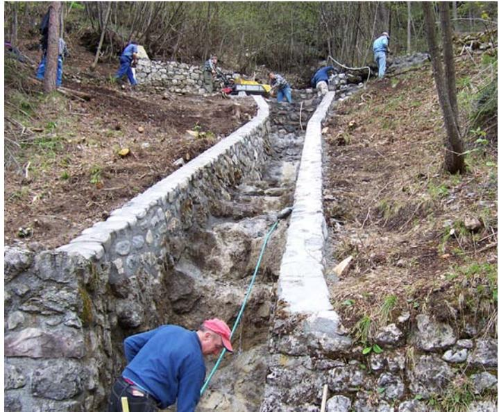
I lavori sono consistiti nel ripristino delle murature spondali e delle soglie di fondo di alcuni affluenti minori di sinistra del torrente Faeit lungo la strada tra la frazione di Pusea e la località Tualis. Si è proceduto inoltre al taglio delle piante che ostacolavano il regolare deflusso delle acque.
