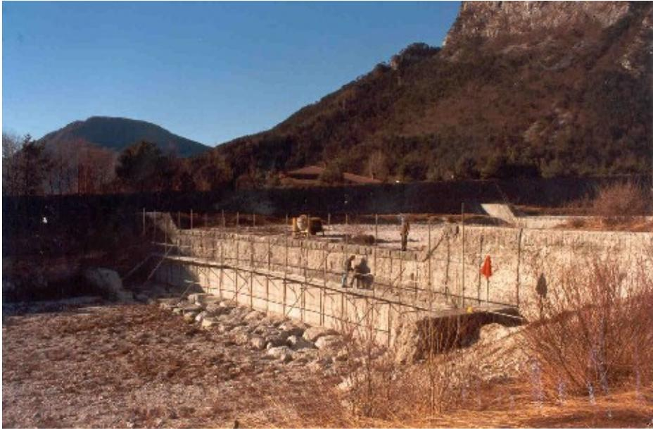
Importante corso d'acqua che confluisce in sinistra nel T. But a valle della città di Tolmezzo, è sistemato con numerose opere che necessitano di manutenzione, già in parte attuata su alcune traverse. Sono stati ripristinati i paramenti di tre opere trasversali con rete elettrosaldata e betoncino e le gavete riparate e fugate. A valle di due briglie è stata necessaria la realizzazione di una platea di dissipazione in grossi massi intasati con calcestruzzo.
