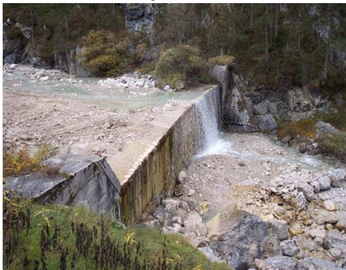
Manutenzione alla gaveta di una briglia e sottofondazione della stessa.
