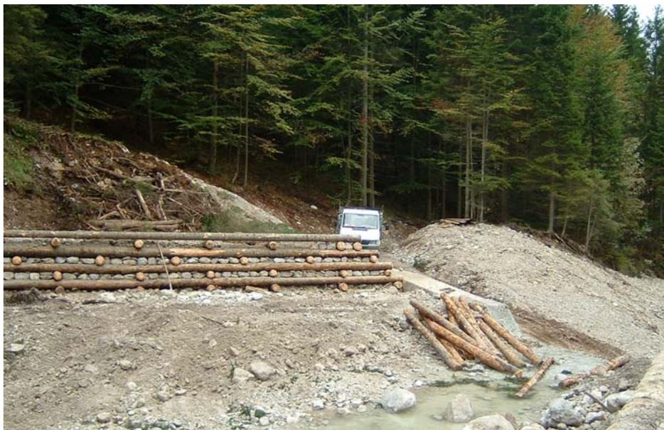
Inalveamento per circa 15.000 mc, demolizione e rifacimento di un ponte che provoca un restringimento notevole alla sezione di deflusso.
