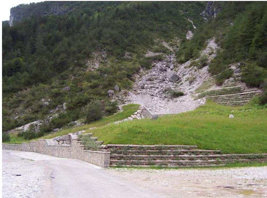
I lavori si sono resi necessari per la manutenzione alle opere longitudinali e trasversali, il consolidamento dei versanti e la messa in sicurezza della strada della Val Cimoliana. I lavori sono consistiti nella realizzazione di briglie, muretti e guado in calcestruzzo rivestite con pietrame,; scogliera in grossi massi a difesa delle sponde, palificate in legname con talee e rinverdimento dell'area.
