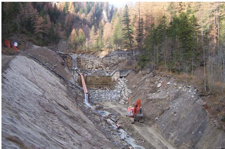
Gli interventi in progetto (due soglie in pietrame recuperato in alveo) hanno lo scopo di ripristinare il piano di scorrimento delle acque ed evitare ulteriori scalzamenti al piede delle strutture esistenti. Allo scopo di facilitare l'inserimento ambientale, si è previsto l'utilizzo di elementi di pietrame provenienti dai lavori di ricalibratura dell'alveo, previsti immediatamente a valle, posizionati su uno strato di 50 cm di calcestruzzo a consistenza di terra umida.
