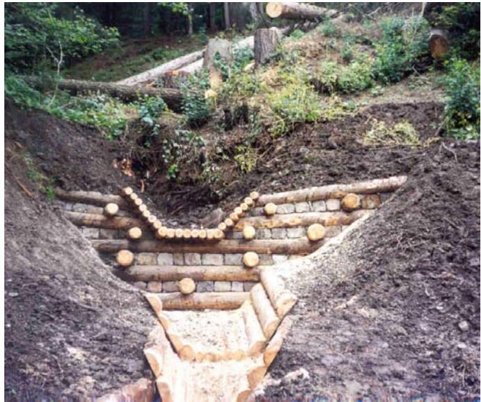
In loc. Chiandarens sono state ripristinate le difese spondali con due tratti di scogliera in grossi massi rinverdite mediante l'inserimento di talee di salice e annegate in calcestruzzo nelle fondazioni. Due piccole frane sono state stabilizzate mediante la formazione di opere miste in legname e pietrame con inserimento di talee nelle ali. Cordonate vegetali sulla superficie della frana e inerbimento potenziato.
