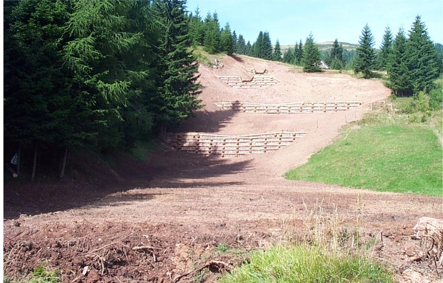
In seguito all'alluvione del 29 agosto 2003 lungo tutta l'asta del T. Uqua e dei suoi affluenti si sono verificate innumerevoli frane. Tutti gli interventi sono stati finalizzati al ripristino della stabilità dei versanti mediante scoronamento, riprofilatura del terreno, realizzazione di opere miste in legname e pietrame, cordone vegetali tipo Praxl, graticciate vive e inerbimento potenziato.
