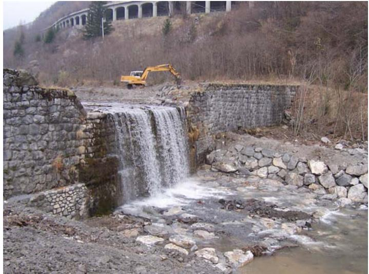
I lavori hanno riguardato la realizzazione di una platea di dissipazione in grossi massi inghiati alla base di un'opera che si presentava con le fondazioni in parte scalzate, nonché il ripristino delle sezioni di deflusso a monte ed a valle dell'opera e la ricostruzione di parte delle difese spondali.
