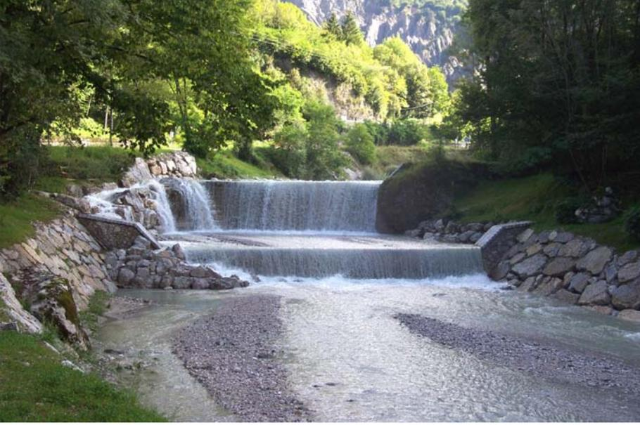
I lavori si sono resi necessari per ripristinare le opere idrauliche longitudinali e trasversali e sono consistiti nella riparazione della gaveta delle briglie, nella realizzazione di scogliere in grossi massi, nel rivestimento della controbriglia con pietrame, nella realizzazione di due rampe di risalita per la fauna ittica. e nella realizzazione di palificate in legname con talee.
