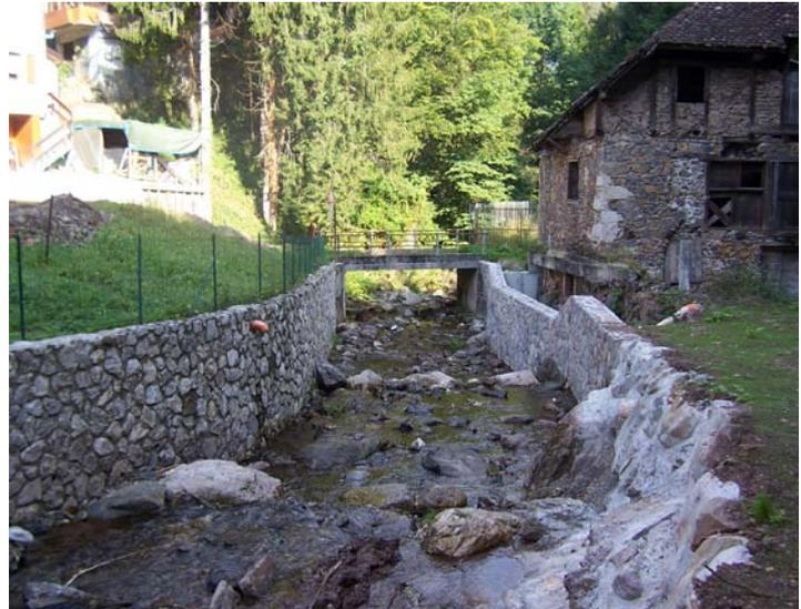
I lavori hanno interessato la sponda destra del Rio Gramulins in prossimità del vecchio mulino e del depuratore. In concreto si è proceduto alla ricostruzione di un tratto di muro spondale in pietrame e malta e di un tratto di circa 35 m di difesa spondale in grossi massi inghisati.
