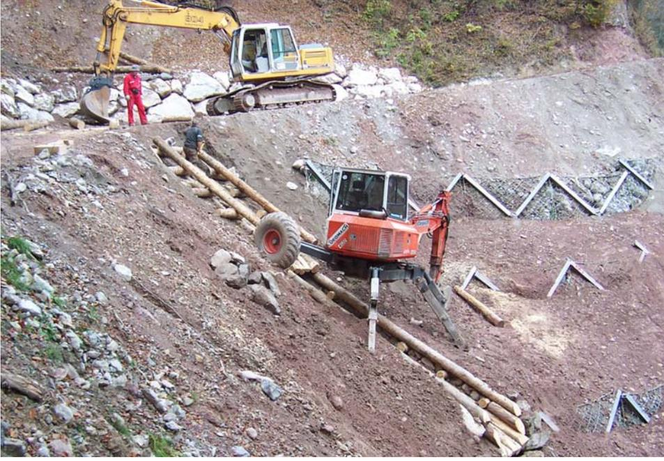
Particolare della sistemazione di un versante in frana con barriere metalliche
