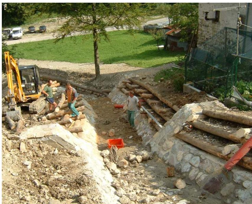
Gli interventi in progetto (canalizzazioni in legname e pietrame con selciato di fondo) hanno lo scopo di ripristinare e consolidare l'alveo, oggetto di forti erosioni localizzate. Allo scopo di facilitare l'inserimento ambientale, si è previsto l'utilizzo di elementi di pietrame, nella parte inferiore, dove più forte è l'azione erosiva; superiormente si è invece realizzata una struttura in legname e pietrame, inerbata e piantumata con astoni di salice.
