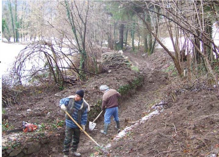
I lavori sono consistiti nel taglio della vegetazione che ostruiva completamente l'alveo, nel ripristino delle sezioni di deflusso e nel recupero delle difese spondali in pietrame.
