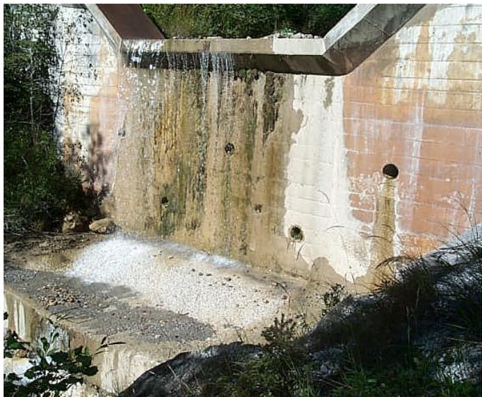
Degli interventi previsti in progetto nel corso del 2005 è stato realizzato solo il rivestimento della platea posta alla base della briglia di quota 770.00 m lungo il corso principale del Rio Minischitte.
