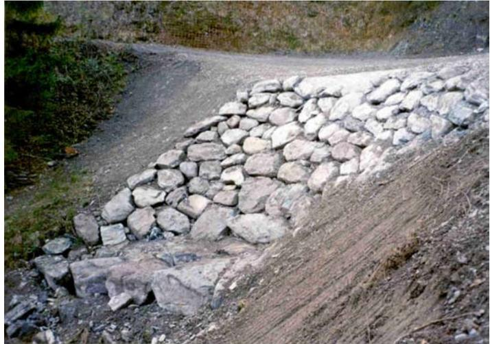
L'intervento è consistito nella ricostruzione di una soglia in pietrame e malta a monte della pista forestale, nella realizzazione di un guado in pietrame e malta e di uno scivolo in grossi massi a valle della strada. Si è inoltre proceduto alla pulizia delle canalette e taglio piante sulle strade forestali attigue.
