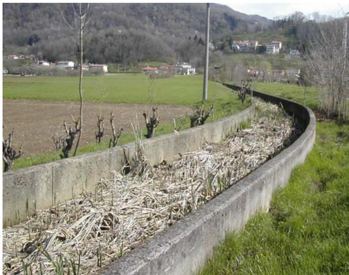
I lavori sono consistiti nel rifacimento del fondo del rio Zupet, nella pulizia dell'alveo del Rio Bosso e nella manutenzione di varie piste mediante l'impiego del trattore con fresa sramatrice e con la pulizia e sostituzione parti deteriorate delle canalette per lo sgrondo delle acque meteoriche.
