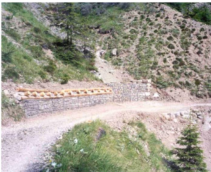
I lavori hanno riguardato la manutenzione e completamento di una serie di manufatti a difesa della viabilità di accesso a Malga Corce: sono stati realizzati alcuni tratti di muratura in gabbioni a sostegno sia della scarpata di valle che di quella di monte, mantenute due soglie, sottofondata parte di una muratura di sostegno della strada. Si è inoltre proceduto al taglio della vegetazione a margine della strada ed alla ricarica con materiale stabilizzato dei tratti maggiormente deteriorati.
