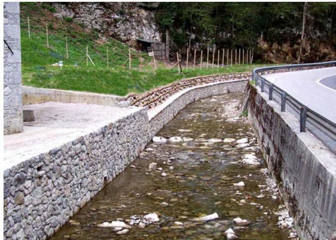
I lavori, resi necessari per ripristinare la sezione di deflusso e consolidare le difese di sponda, sono consistiti nella realizzazione di un muro in pietrame e una soprastante palificata viva in legname e pietrame a consolidamento degli strati superficiali del terreno.
