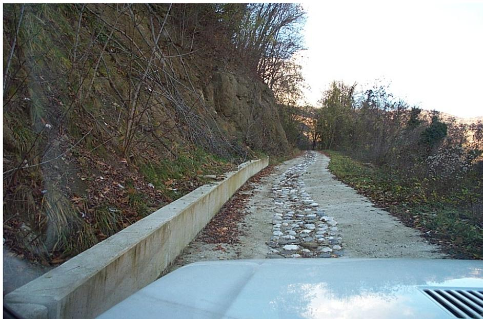
I lavori sono consistiti nella manutenzione di una frana sistemata nel 1990 e denudata a causa dell'aridità dei suoli mediante la formazione di cordone vive e l'inerbimento mediante "mulching" inoltre è stata sistemata la pista in corrispondenza di alcuni tornanti con la realizzazione di selciato in calcestruzzo. Sono stati anche sistemati due cedimenti della scarpata a valle mediante la realizzazione di geomuri ed opere in legname e pietrame.
