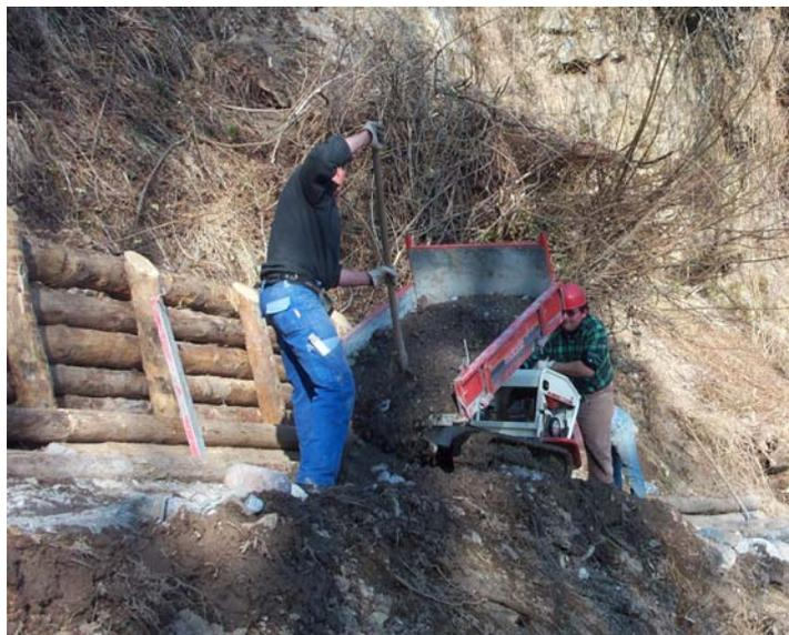
I lavori hanno riguardato la sistemazione di un tratto di versante lungo una strada vicinale mediante la raccolta e allontanamento delle acque di risorgiva con un canale in pietrame e leganeme ed il consolidamento della scarpata di monte con opere in legname e cordionate con talle di salice.
