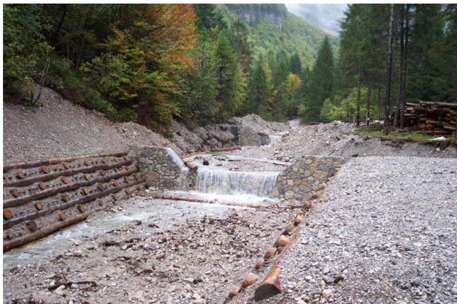
I lavori si sono resi necessari per il ripristino della sezione idraulica del corso d'acqua, il consolidamento dei versanti e la messa in sicurezza in prossimità dell'attraversamento della strada statale 251. I lavori sono consistiti nella realizzazione di briglie in calcestruzzo rivestite con pietrame, palificate in legname con talee e rinverdimento dell'area.
