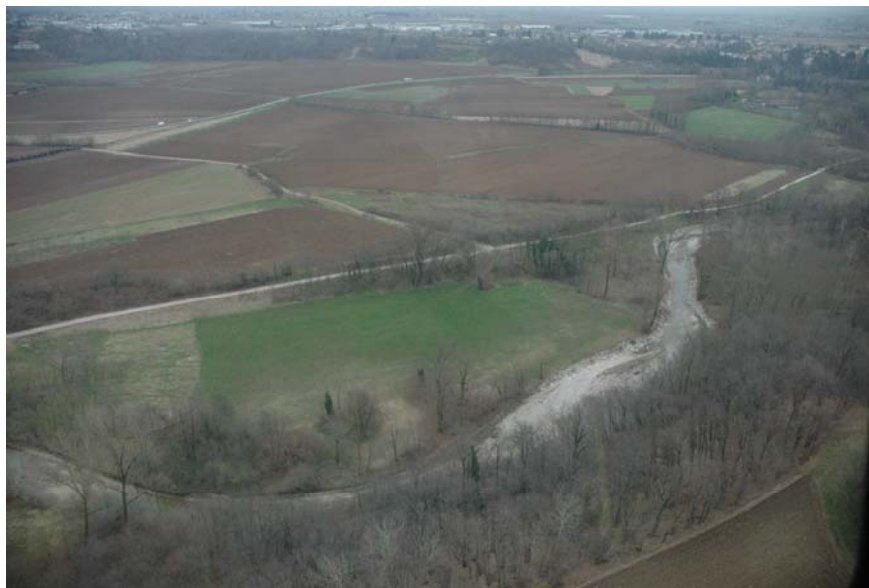
Figura 8.7.3: Vista aerea dell'area della zona di presa
