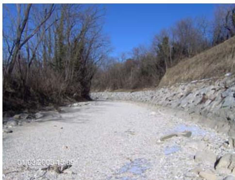
Figura 7.4.2: Alveo del torrente Cormor a Udine (V.le dello Sport-Autostrada A28)
