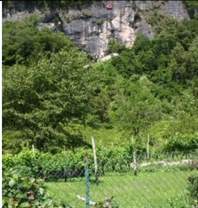
Fig. 8: la parete rocciosa, la Chiesetta di San Candido (quota altimetrica di partenza) e la quota altimetrica di arrivo per la centrale micro idro elettrica
