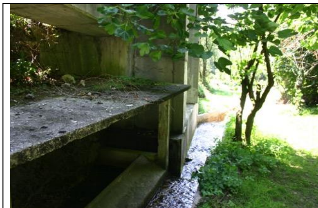
Fig. 10 vecchio lavatoio comunale (il manufatto è privo di vincoli storico architettonici)
