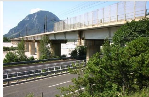
**Fig. 4** dopo aver attraversato la sede autostradale, la condotta idrica effettua un altro salto di circa 10 metri per immettersi sul fiume Fella
