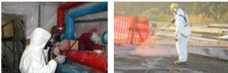
*Nelle foto, rispettivamente: rimozione di guarnizioni termoidrauliche (amianto friabile) all'interno di un cantiere confinato ipobarico e rimozione di lastre in cemento amianto (materiale compatto) da una copertura industriale.*
