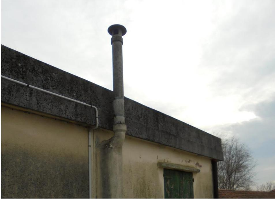
VISTA DI UNA DELLE DIVERSE COMPONENTI IN CEMENTO AMIANTO DA RIMUOVERE
