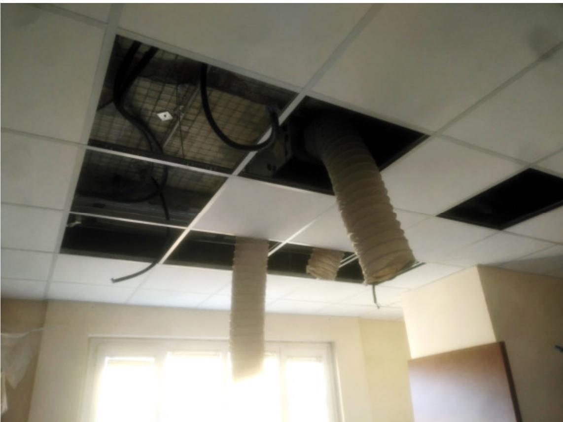
Anche gli impianti, le canalizzazioni per il trasporto aria e i tubi dell'acqua e le canale per i cavi elettrici devono essere appese con ripartitori adeguati e barre filettate ancorate con tasselli ai travetti.
