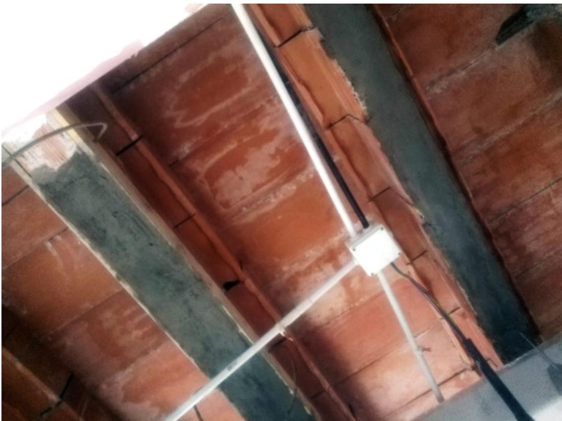
Sul travetto ricostruito si procede con applicazione di rete elettrosaldata d2mm/50\*50mm e **controsoffitto ispezionabile** in quadrotti di fibra di vetro collegati ai travetti del solaio mediante tasselli meccanici.
