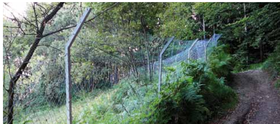
Una recinzione di tipo tradizionale, adatta a evitare l’entrata di canidi.
