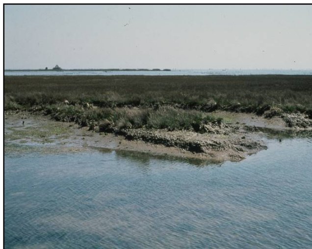
Figura 4.5.153. Bordo di barena soggetto ad erosione in località Bioni in laguna di Marano.
